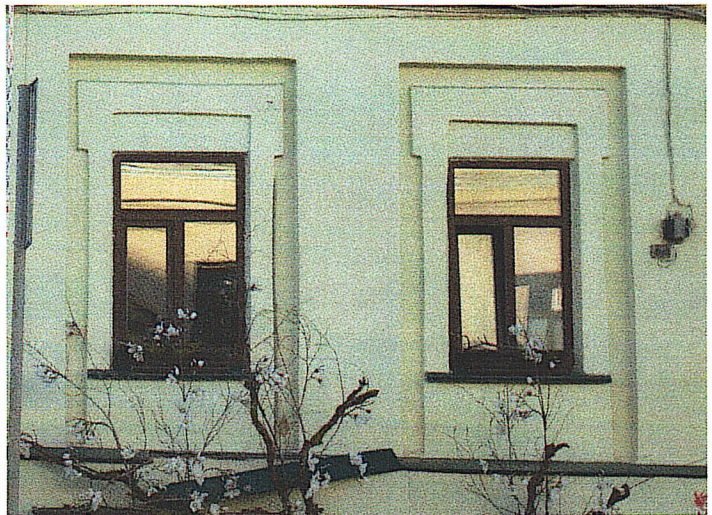
Рис. 24. Оконные проемы 1 этажа
