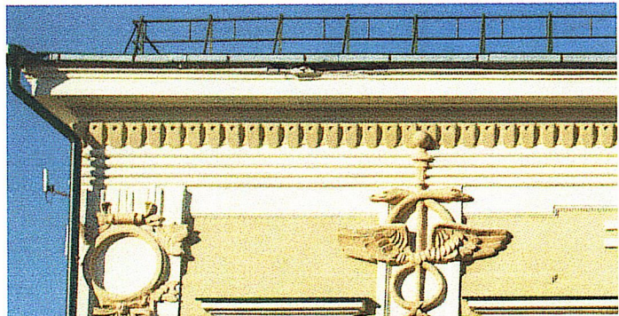
Рис. 16. Венчающий профилированный карниз с горизонтальными рядами валика, иоников; ниша сложной формы на фризе
