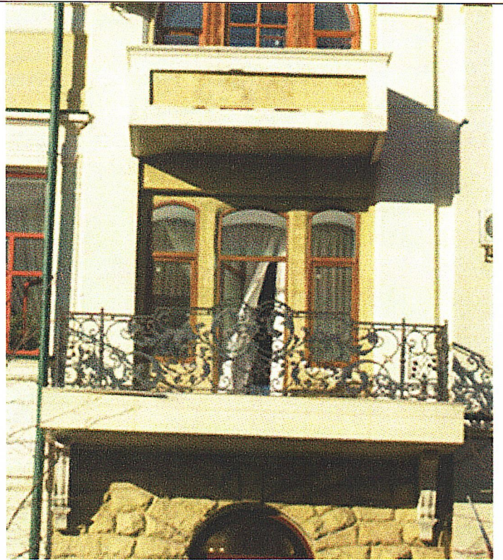
Рис. 12. Два балкона с глухим ограждением
