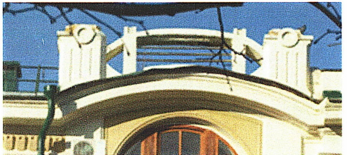
Рис. 13. Аттик с криволинейным верхом
