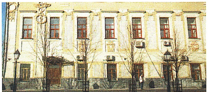
Рис. 14. Плоская горизонтальная межэтажная тяга
