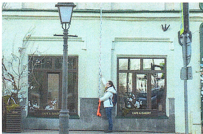
Рис. 21. Оконные проемы первого этажа; межэтажный профилированный пояс
