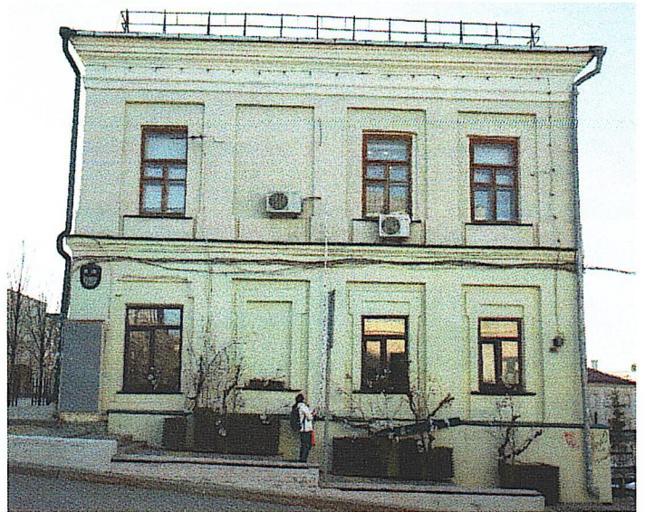
Рис. 23. Фасад по ул.Чернышевского
