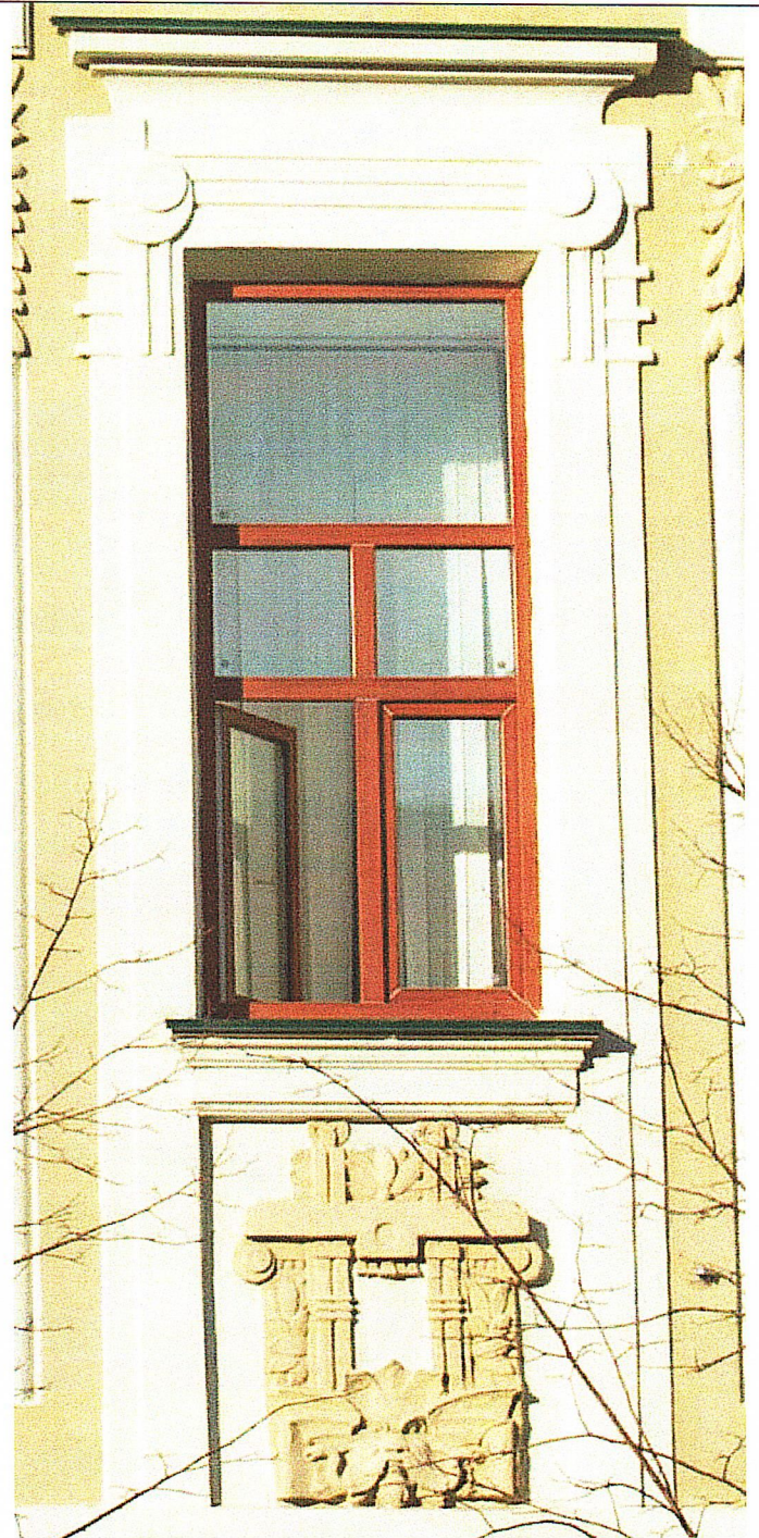
Рис. 15. Наличники оконных проемов 2 этажа
