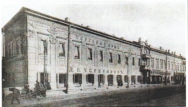
Рис. 42. Столярные заполнения (архивная фотография, 1905 г.)
