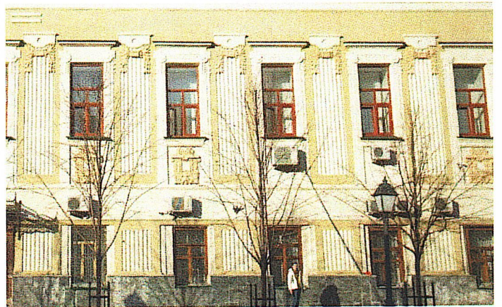
Рис. 11. Стилизованные пилястры с каннелюрами, фризом и капителью
