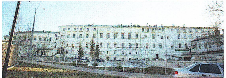
Рис. 39. Дворовый фасад (характер отделки фасадов – гладкая штукатурка с окраской)
