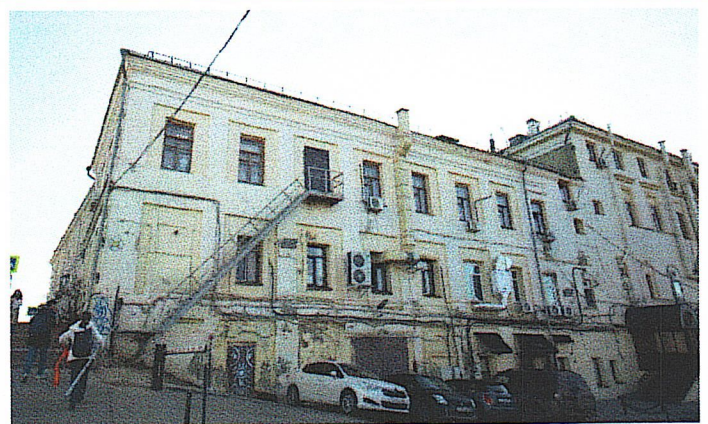
Рис. 25. Общий вид части дворового фасада
