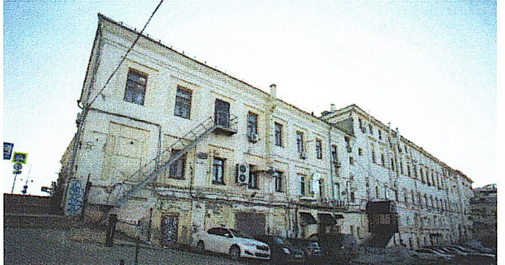
Рис. 38. Вид со двора (характер отделки фасадов – гладкая штукатурка с окраской)
