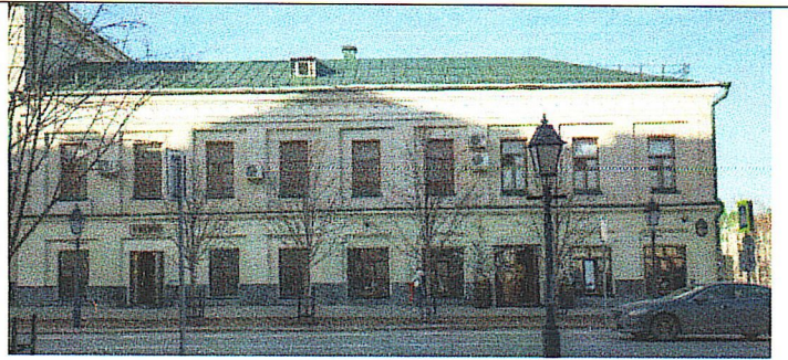
Рис. 36. Вид по ул. Кремлевской (характер отделки фасадов – гладкая штукатурка с окраской)
