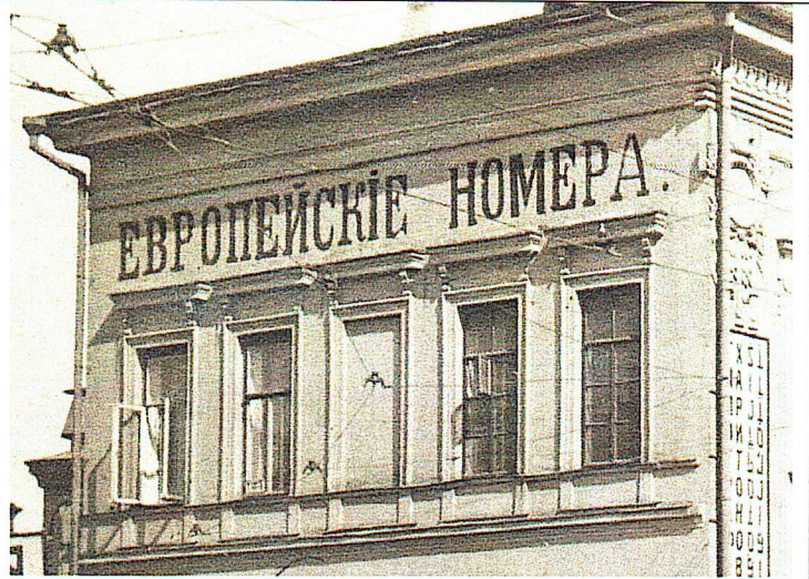
Рис. 33. Тонкий декоративный пояс с тумбами под оконными проемами второго этажа; профилированные наличники с сандриками на двух кронштейнах оконных проемов второго этажа; межэтажная профилированная тяга; высокий профилированный венчающий карниз
