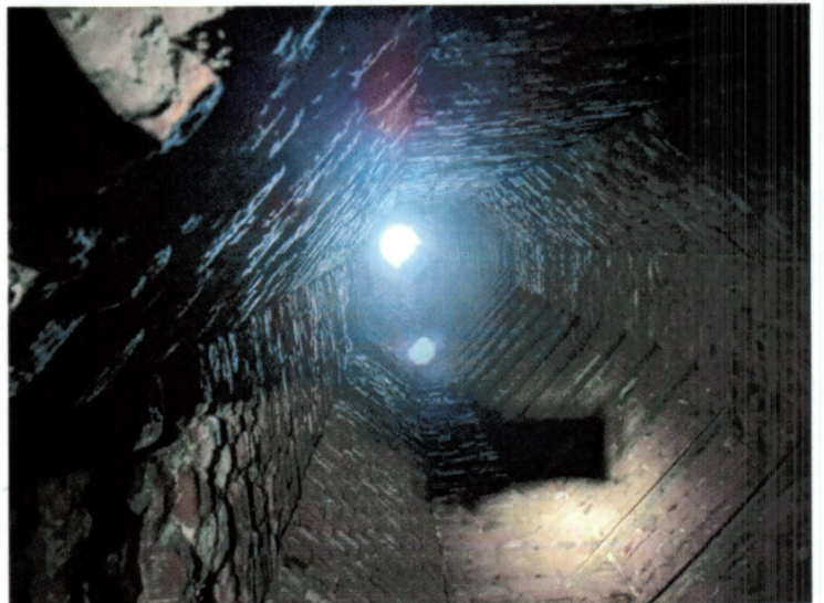
Рис. 9. Внутренние закладные ступени
