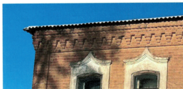
Рис. 12. Оформление венчающего карниза
