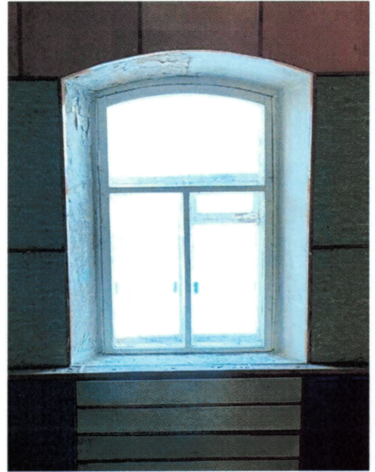
Рис. 28. Оконный проем второго этажа
