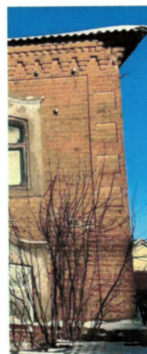
Рис. 13. Оформление угловых лопаток
