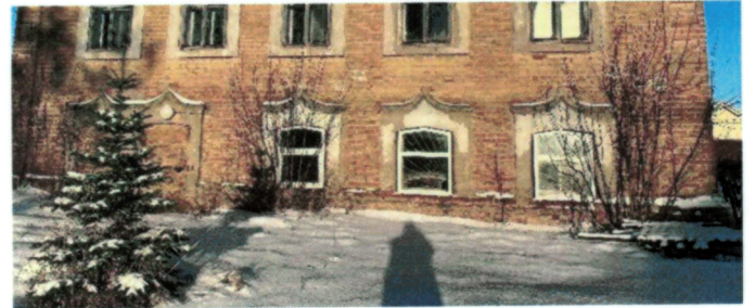
Рис. 9. Оконный ряд по 1-му этажу главного фасада Оформление оконных проемов
