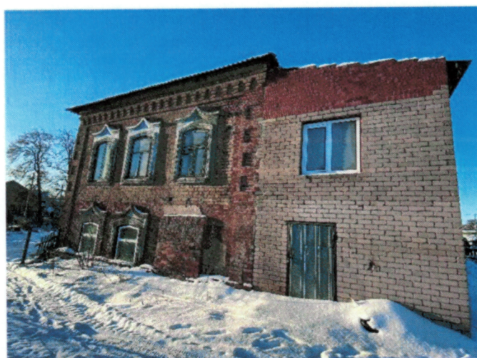
Рис. 14. Общий вид торцевого дворового фасада
