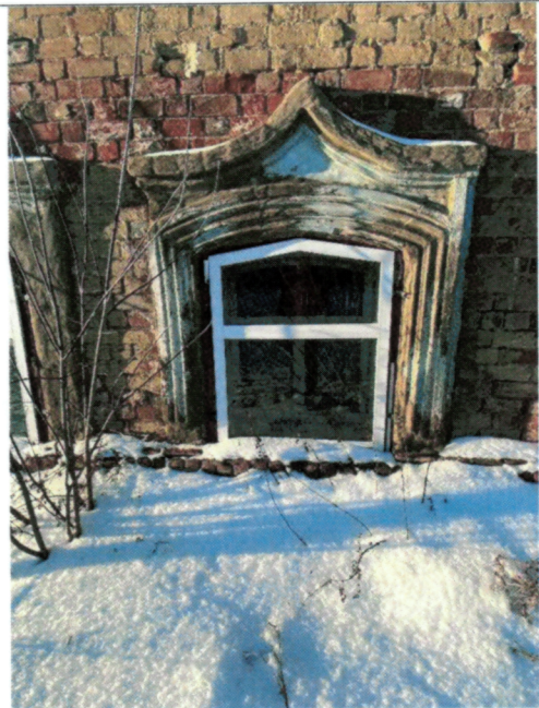
Рис. 15. Фрагмент торцевого дворового фасада. Оформление оконных проемов
