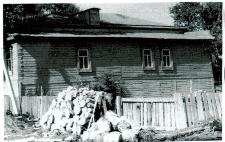
Рис. 20. Горизонтальная обшивка тесовой доской, окраска
