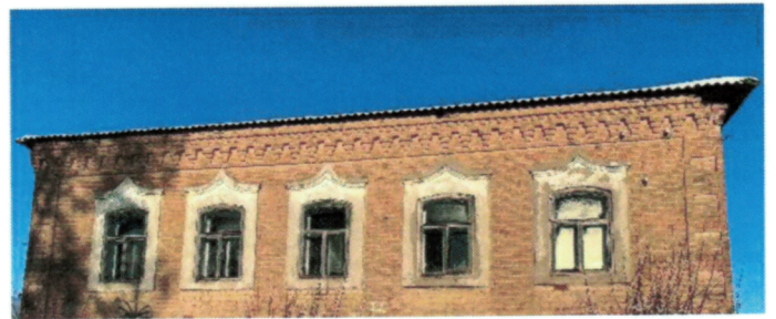
Рис. 8. Оконный ряд по 2-му этажу главного фасада оформление оконных проемов
