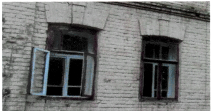
Рис. 17. Оконные проемы 1-го этажа с выступающими лучковыми перемычками и замковыми камнями
