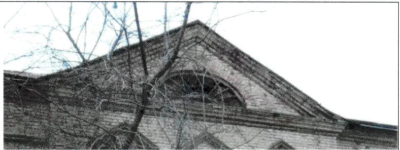
Рис. 10. Треугольный фронтон центрального ризалита с полуциркульным оконным проемом
