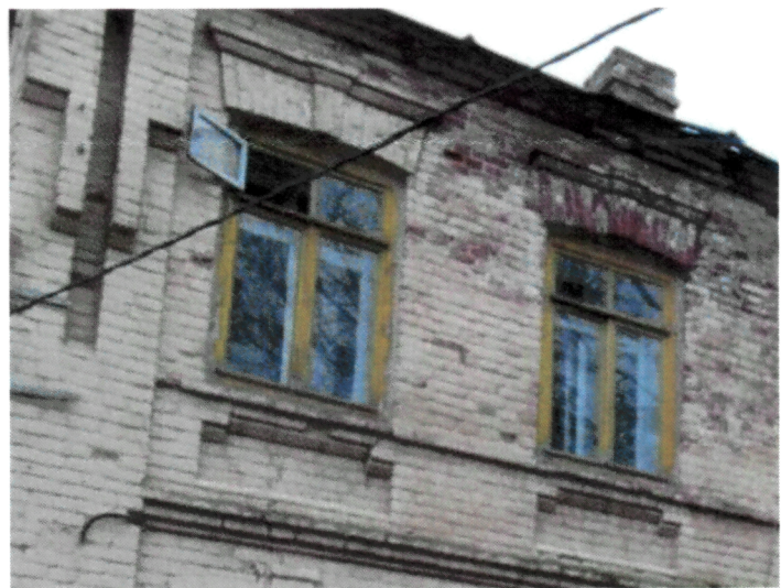
Рис. 18. Оконные проемы 2-го этажа с выступающими лучковыми перемычками, замковыми камнями и сандриками в виде прямого раскрепованного профилированного карниза
