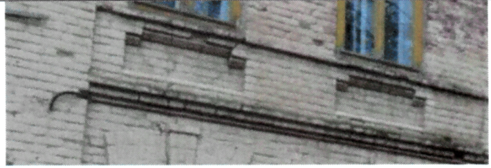
Рис. 19. Профилированный междуэтажный пояс; пояс простого профиля, проходящий в уровне подоконника под оконными проемами второго этажа; декоративные подоконные ниши окон второго этажа
