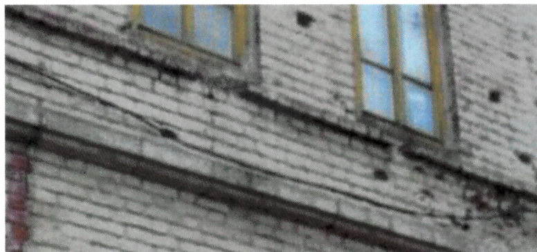
Рис. 14. Профилированный междуэтажный пояс; пояс простого профиля, проходящий в уровне подоконника под оконными проемами второго этажа
