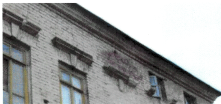
Рис. 15. Профилированный венчающий карниз
