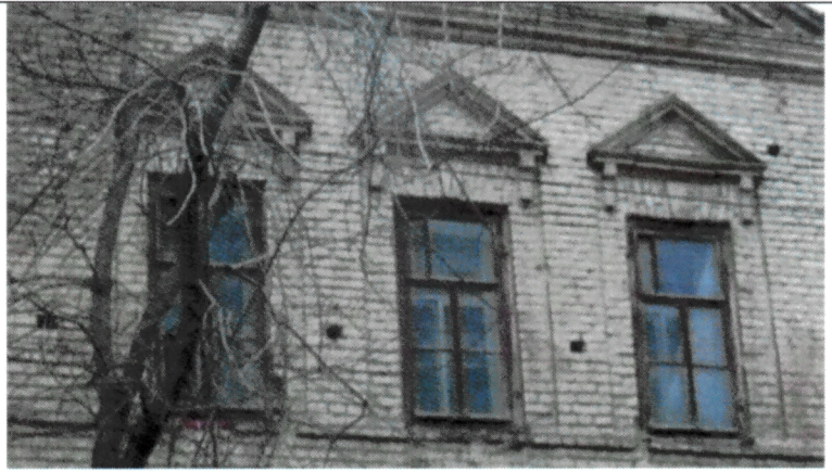
Рис. 7. Оконные проемы 2-го этажа центральной части фасада с треугольными профилированными сандриками на кронштейнах и замковыми камнями
