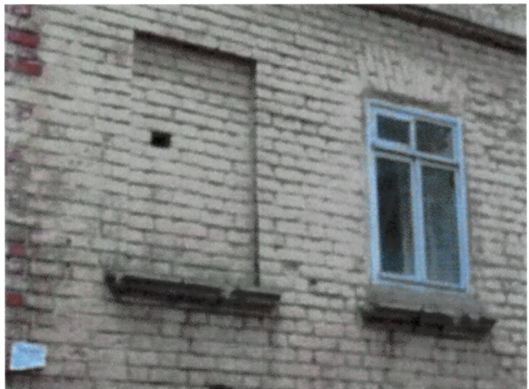
Рис. 12. Оконные проемы и ниши первого этажа, по форме – близкие к квадратным, с подоконными полочками
