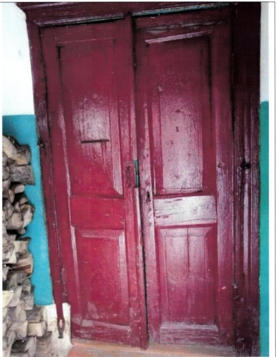
Рис. 23. Филенчатые двери парадного входа.
