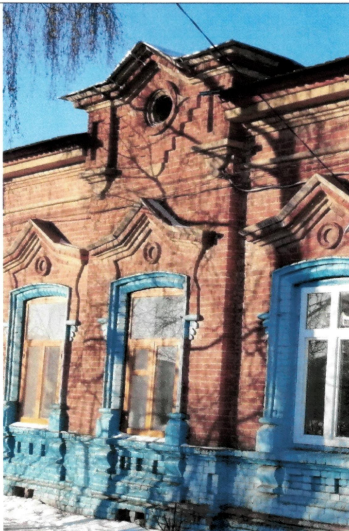
Рис. 10. Фрагмент фасада с раскреповкой плоскости стены
