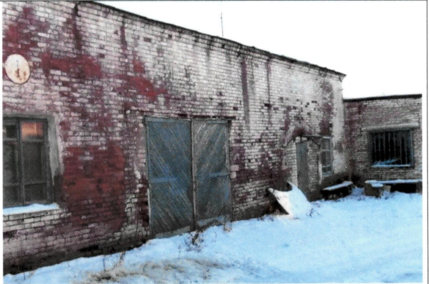
Рис. 7. Дворовой фасад хозяйственной постройки.
