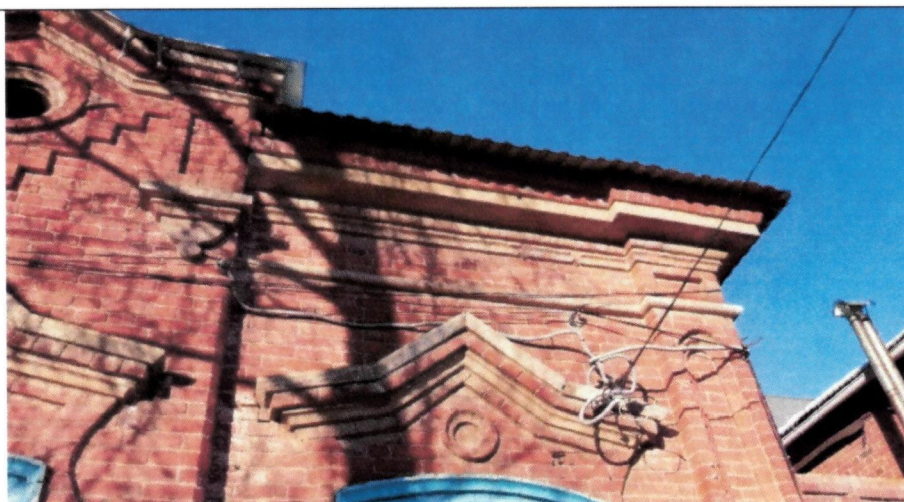
Рис. 14. Венчающий карниз главного фасада
