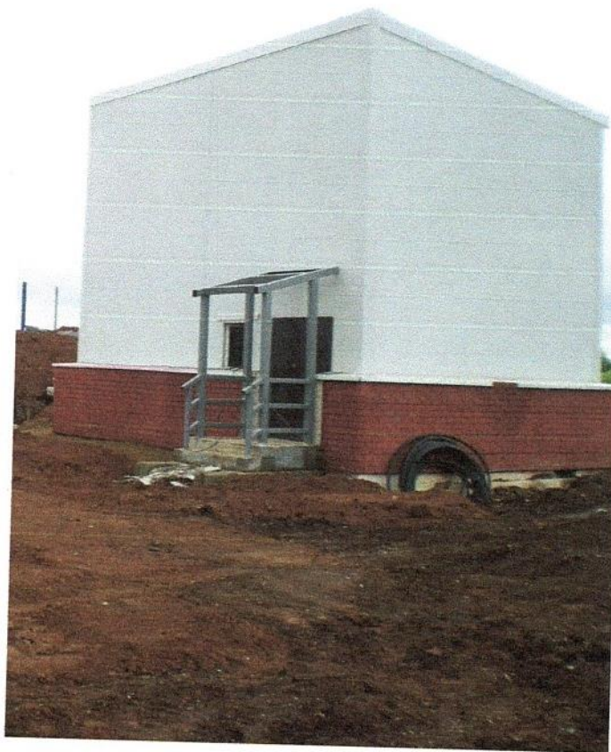
Фото 1. Здание насосной станции
