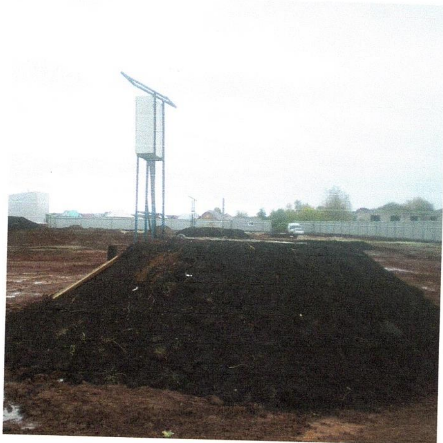
Фото 2. Вид колодца в процессе «обваловки»
