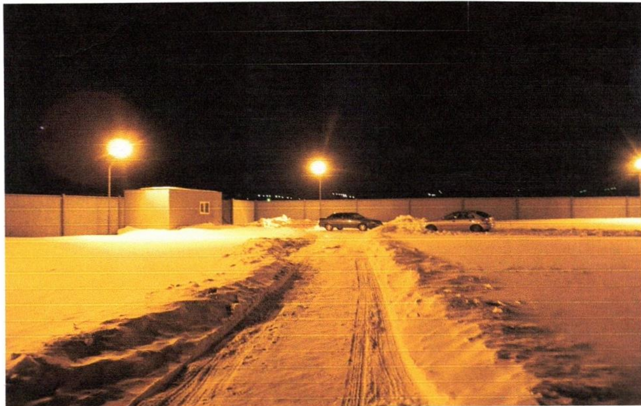
Фото 5. Ограждение и освещение водозабора, КПП.
