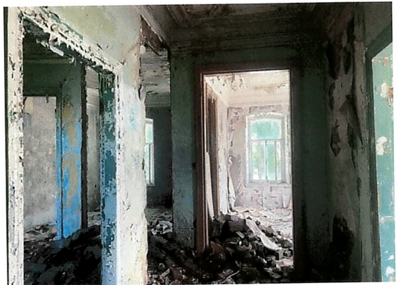
Рис. 19. Фрагмент помещения 2-го этажа
