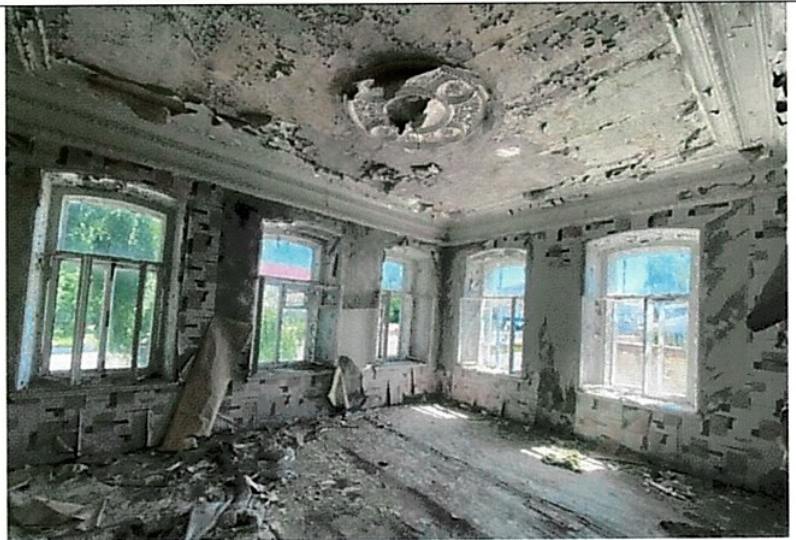
Рис. 23. Софитного карниза с рядом иоников, жгутов и листов аканта и лепной круглой розеткой с растительным орнаментом по центру потолка 2-го этажа
