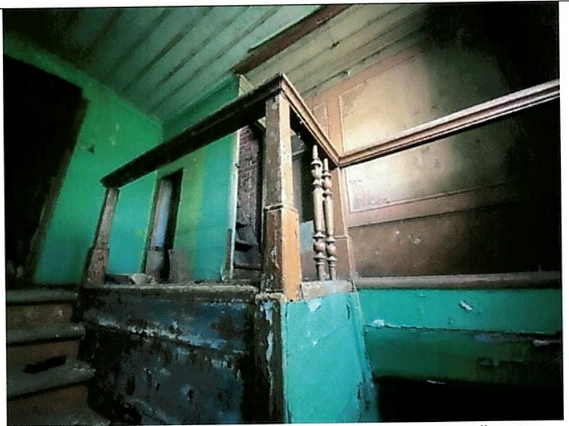
Рис. 17. Историческая лестница с росписью стены лестничной клетки
