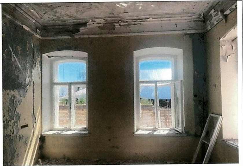
Рис. 20. Фрагмент помещения 2-го этажа
