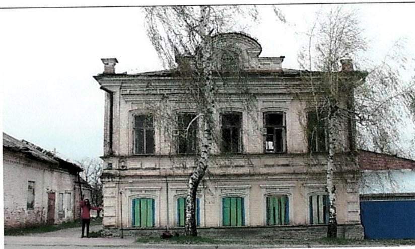
Рис. 7. Главный (восточный) фасад
