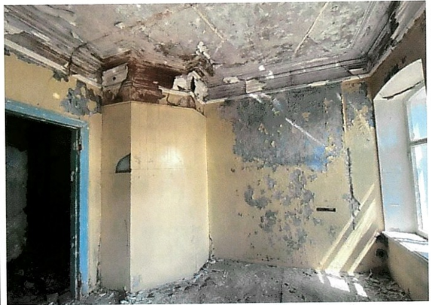
Рис. 21. Фрагмент помещения 2-го этажа с диагональной печью и профилированными потолочными тягами
