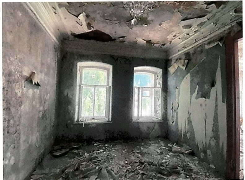
Рис. 24. Фрагмент помещения 2-го этажа с профилированными тягами
