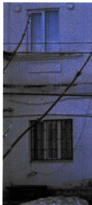
Рис. 19. Окна первого и второго этажа
