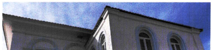
Рис. 16. Венчающий карниз
