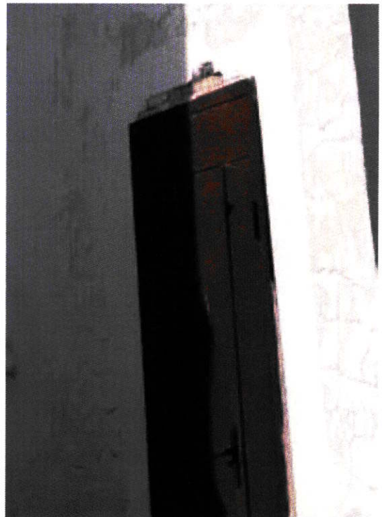
Рис. 14. Дверной проем первого этажа
