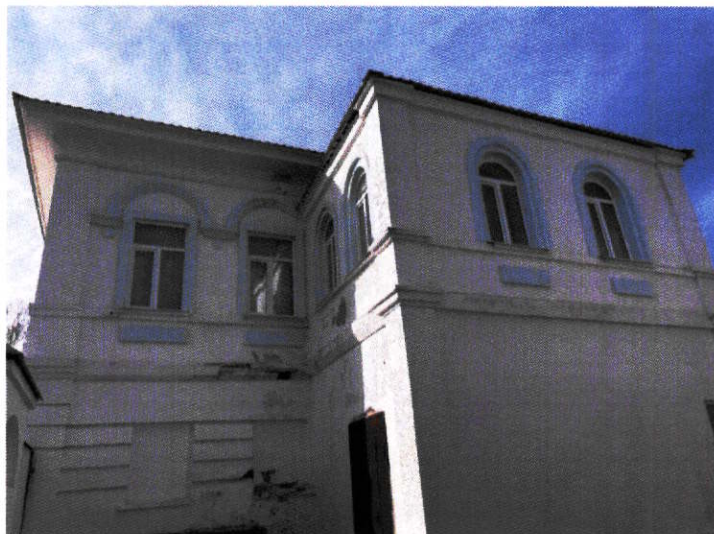
Рис. 10. Вид на юго-восточный фасад
