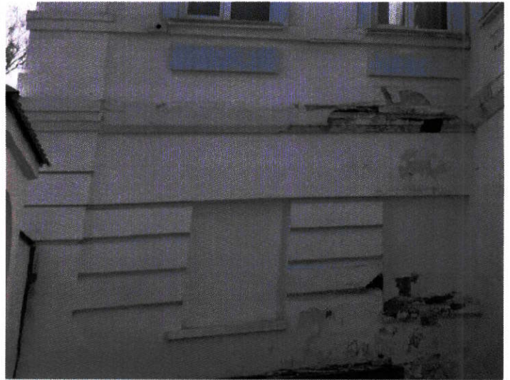
Рис. 13. Оконные проемы (заложенные) первого этажа
