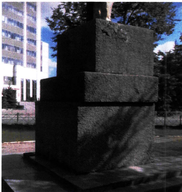
Рис. 6. Постамент с западной стороны
