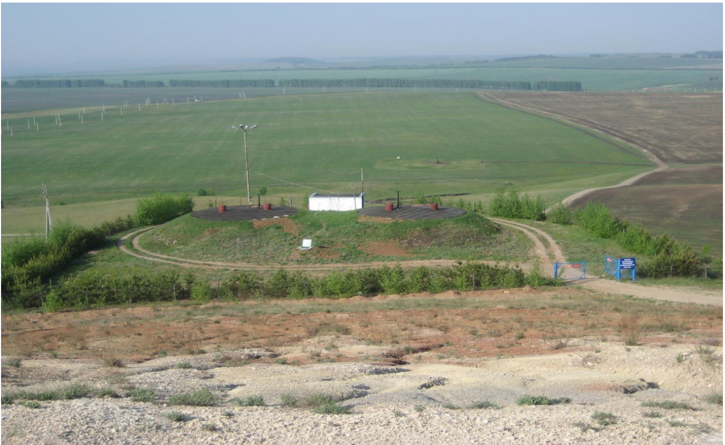
Резервуар чистой воды на Чатринском водозаборе
