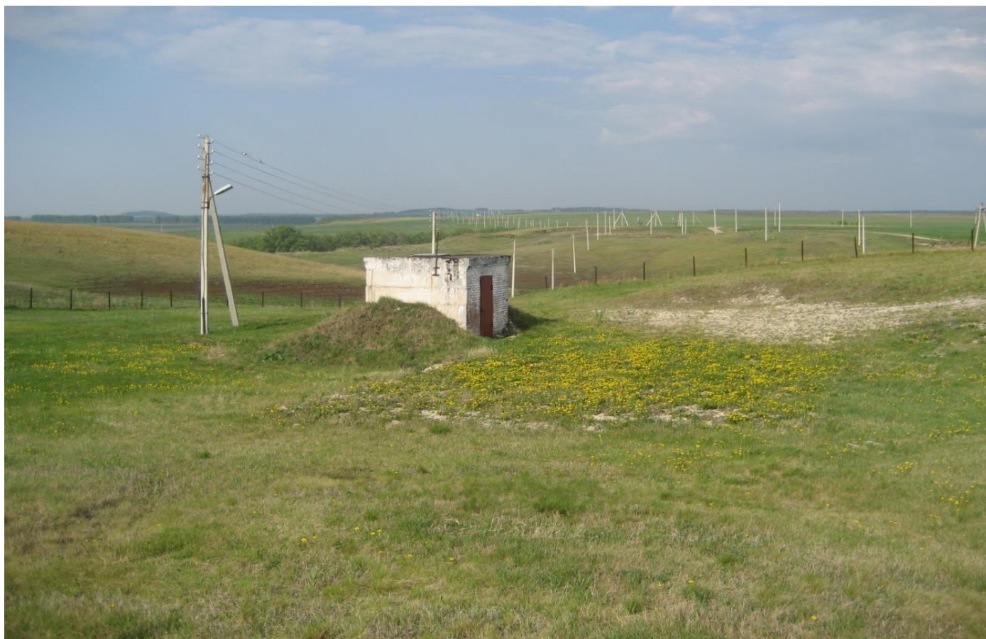
Скважина Чатринского водозабора
