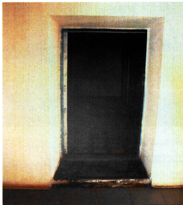
Рис. 26. Прямоугольные дверные проемы
