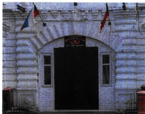
Рис. 11. Дверной проем. Бывшая проездная арка
