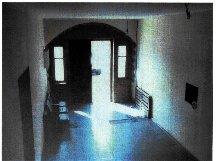
Рис. 24. Арочный свод бывшей проездной арки
