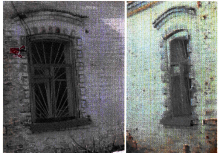
Рис.18. Окна первого этажа
