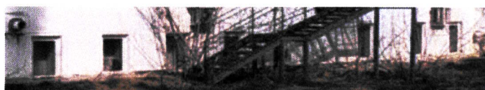
Рис. 17. Оконные проемы первого этажа
