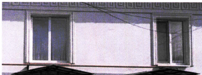
Рис. 13. Оконные проемы второго этажа
