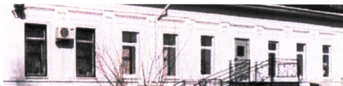
Рис. 18. Оконные проемы второго этажа
