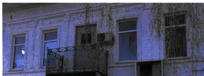
Рис. 24. Оконные проемы второго этажа
