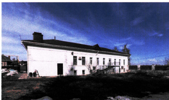
Рис. 15. Вид на юго-западный фасад
