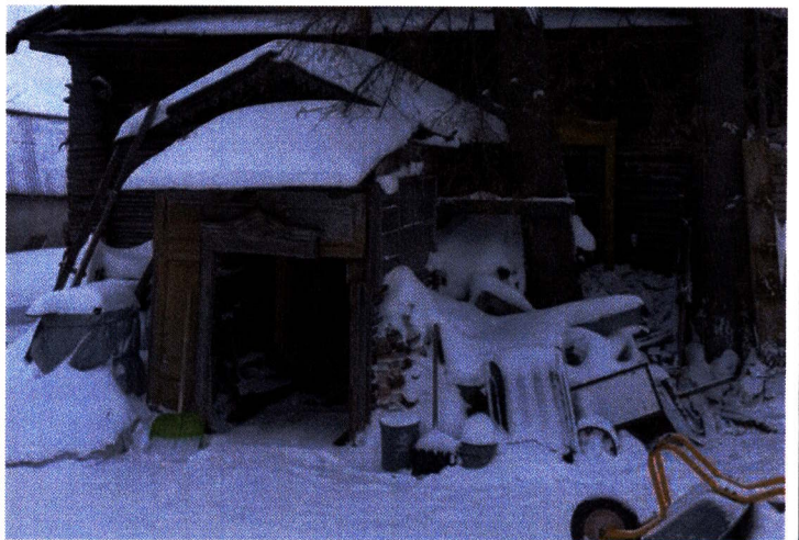
Рис. 10. Фрагмент юго-восточного фасада
