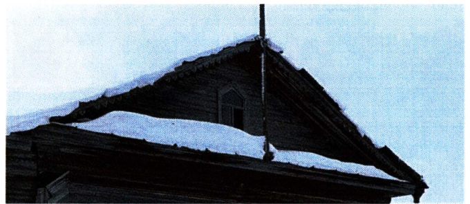
Рис. 7. Фрагмент северо-западного фасада
