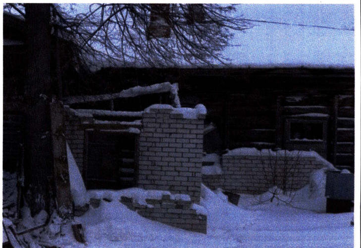
Рис. 11. Фрагмент юго-восточного фасада
