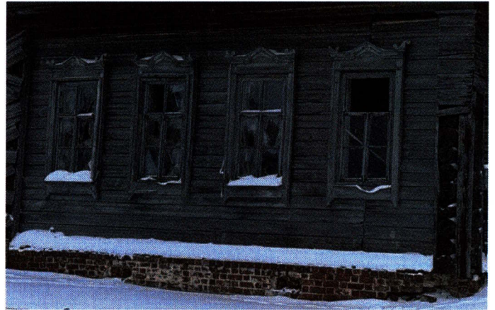
Рис. 6. Фрагмент северо-западного фасада
