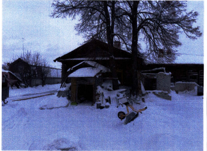
Рис.9. Фрагмент юго-восточного фасада
