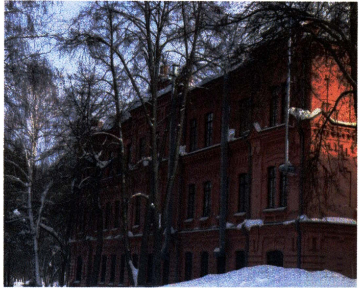
Рис. 19. Общий вид на западный фасад трехэтажного объема (Литер А1)
