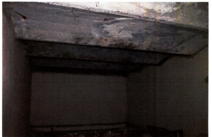
Рис. 14. Трехэтажный объем (Литер А1). Своды типа «Монье»
