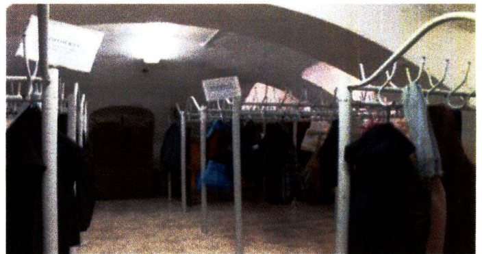
Рис. 12. Двухэтажный объем (Литер А). Сводчатое помещение цокольного этажа
