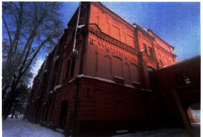
Рис. 20. Фрагмент вида на южный фасад трехэтажного объема (Литер А1)
