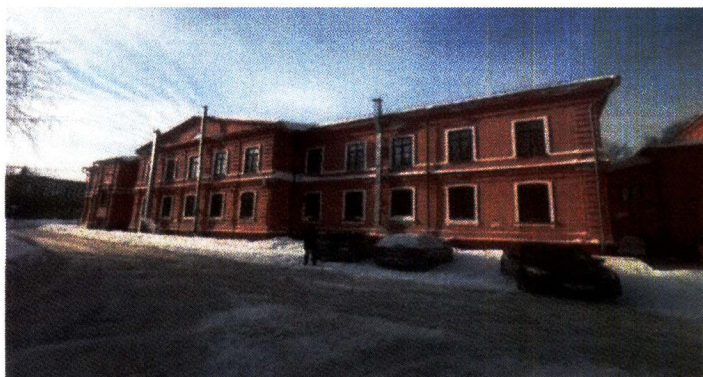
Рис. 27. Общий вид на восточный фасад двухэтажного объёма (Литер А)
