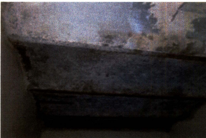
Рис. 45. Трехэтажный объем (Литер А1). Своды типа «Монье» под площадками лестниц
