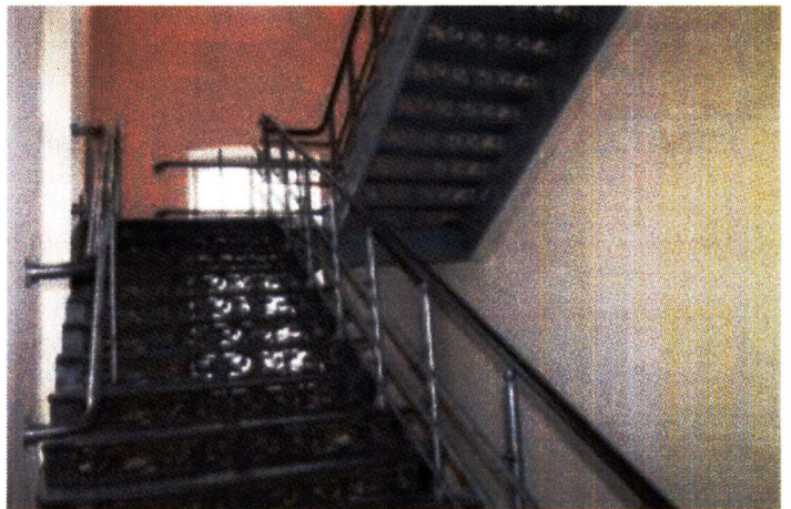
Рис. 42. Трехэтажный объем (Литер А1). Одна из двух подлинных лестниц (заменены ограждения)
