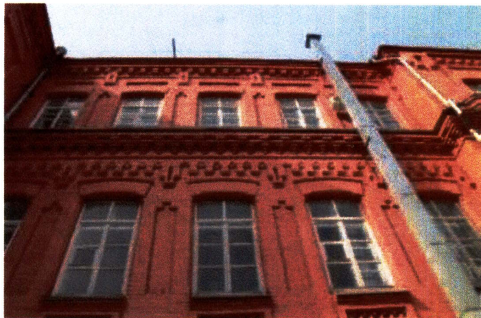
Рис. 23. Трехэтажный объем (Литер А1). Оформление оконных проемов, междуоконных плоскостей второго, третьего этажей, оформление междуэтажного и венчающего карнизов
