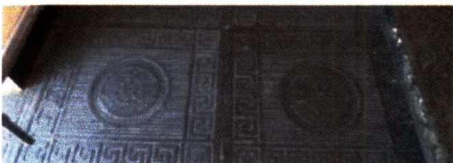
Рис. 44. Трехэтажный объем (Литер А1). Лестница (вторая из двух), ступени, подступенки и площадки
