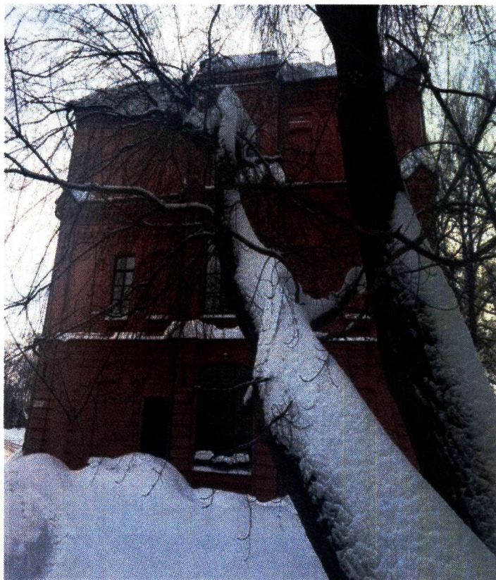
Рис. 18. Фрагмент вида на северный фасад трехэтажного объема (Литер А1)
