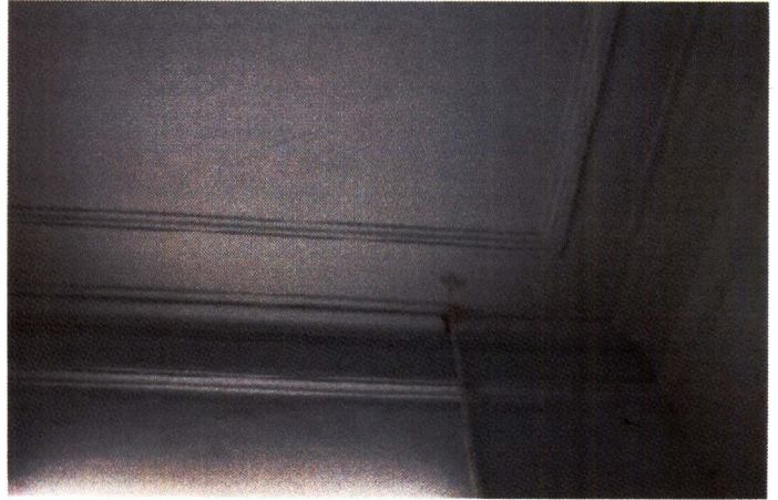
Рис. 40. Двухэтажный объем (Литер А). Потолочные тяги черной (второстепенной) лестницы
