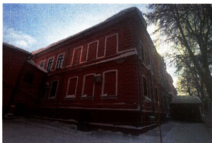
Рис. 29. Фрагмент вида на северный фасад двухэтажного объема (Литер А)
