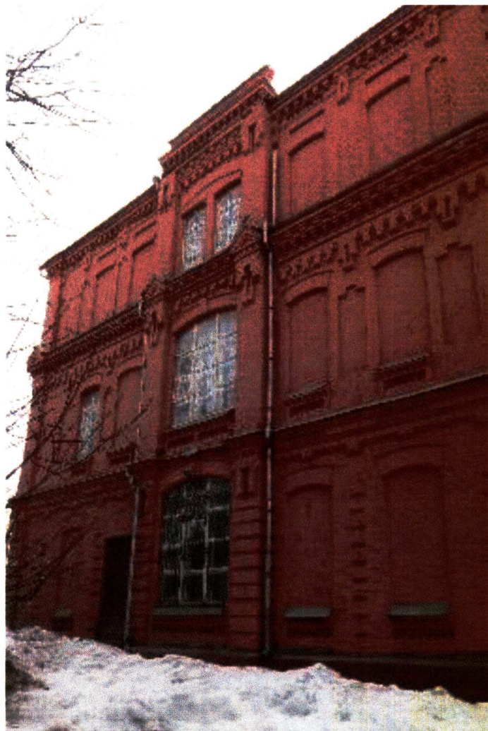
Рис. 24. Трехэтажный объем (Литер А1). Подлинные ниши, оформление оконных проемов, подоконных и надоконных плоскостей, междуэтажных и венчающего карнизов, аттик ризалита
