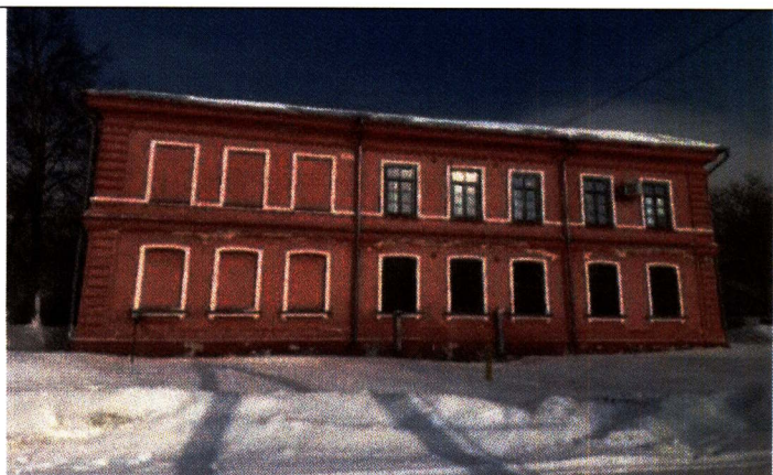
Рис. 28. Общий вид на боковой южный фасад двухэтажного объема (Литер А)
