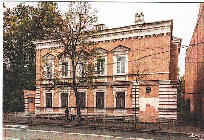
Рис.3. Вид с севера
