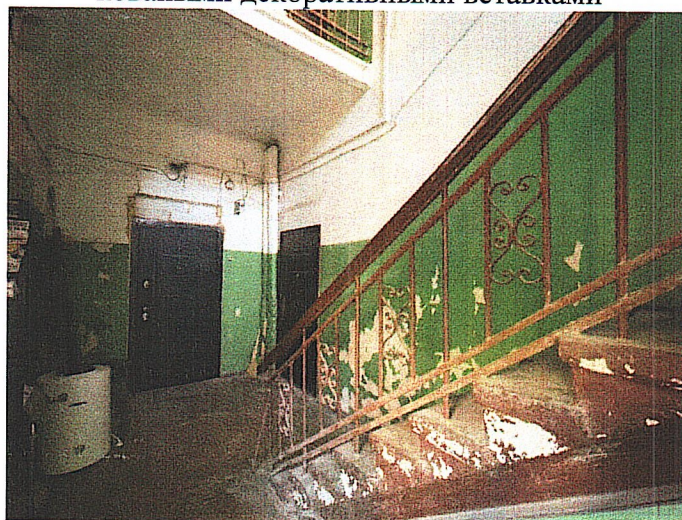
Рис.10. Металлическое ограждение лестницы с коваными декоративными вставками
