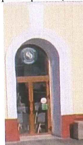
Рис.16. Шестой дверной проем
