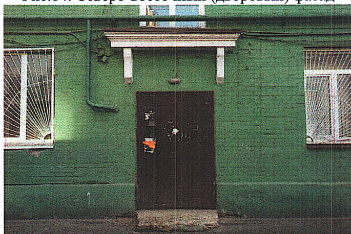
Рис.15. Сандрик-полочки на кронштейнах над дверными проемами
