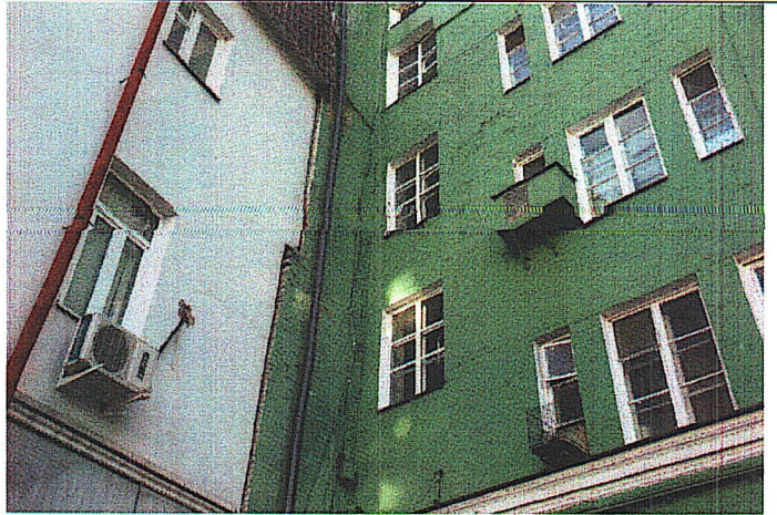
Рис.16. Оконные проемы прямоугольной формы
