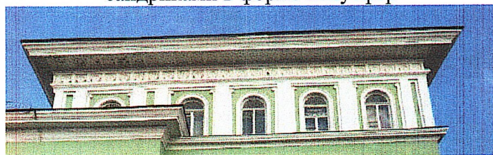
Рис.10. Арочные оконные проемы в многопрофильных наличниках
