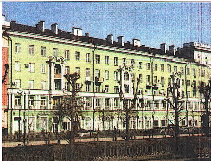
Рис.4. Общий вид фасада
