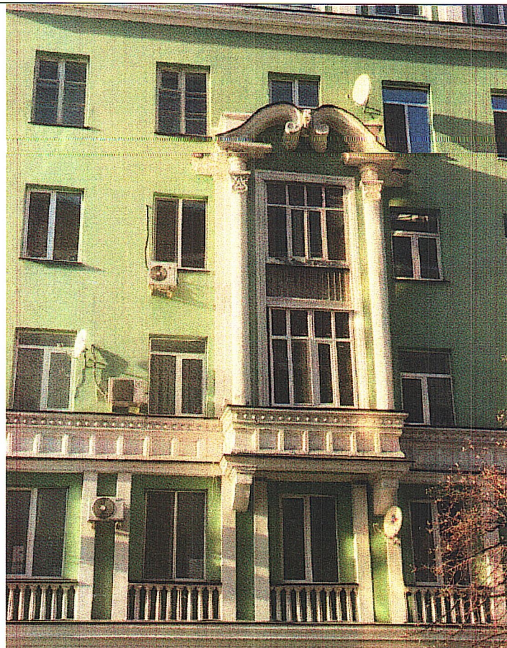
Рис.11. Эркер главного фасада. Балюстрады под окнами
