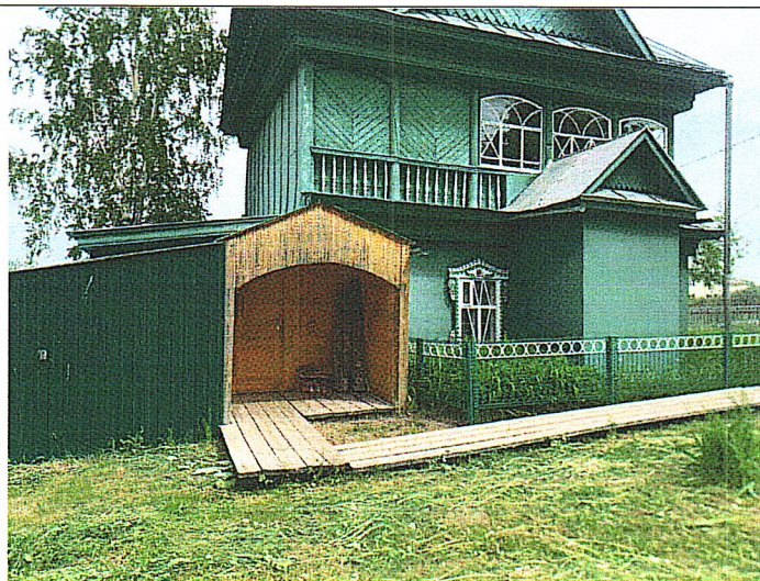
Рис.6. Общий вид на южный фасад. Два фальшокна
