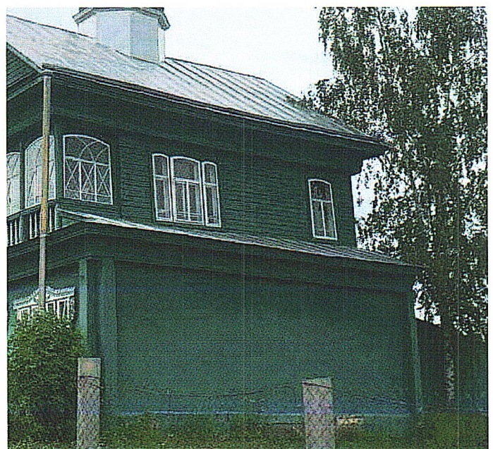
Рис.9. Общий вид на северный фасад
