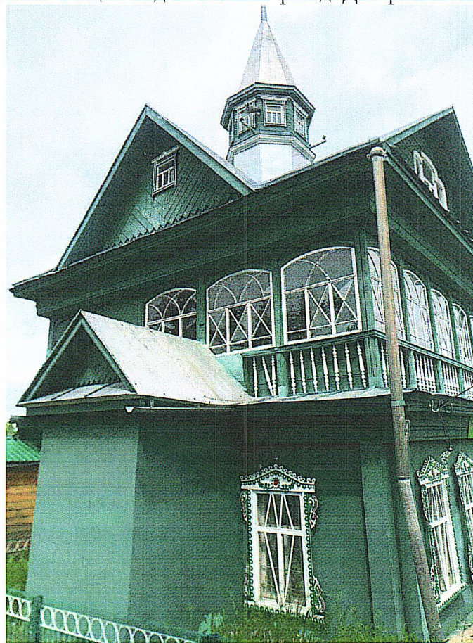
Рис.7. Общий вид на южный фасад
