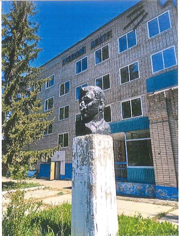
Рис.3. Вид с юго-запада
