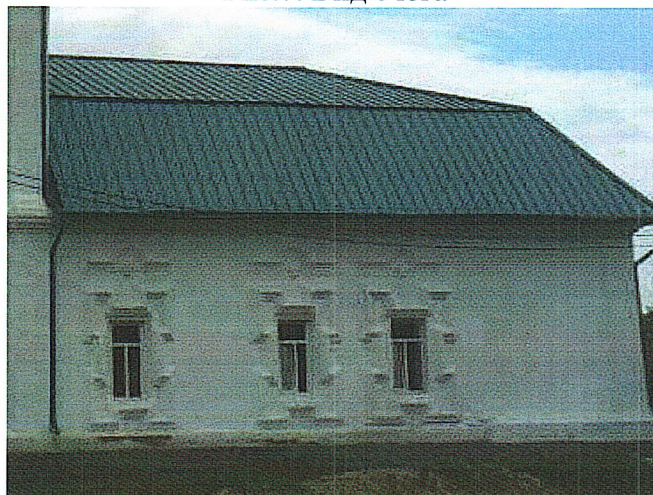
Рис.8. Вид с севера
