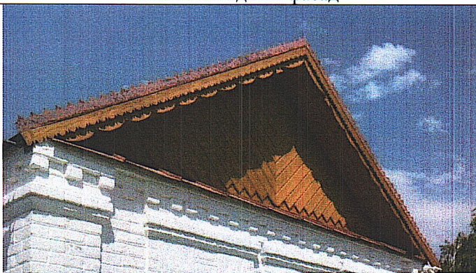
Рис.10. Крыша. Вид с юго-востока
