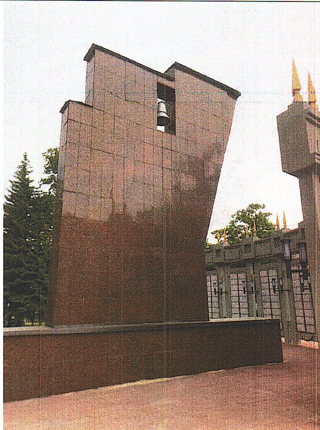
Рис.6. Вид с юго-запада
