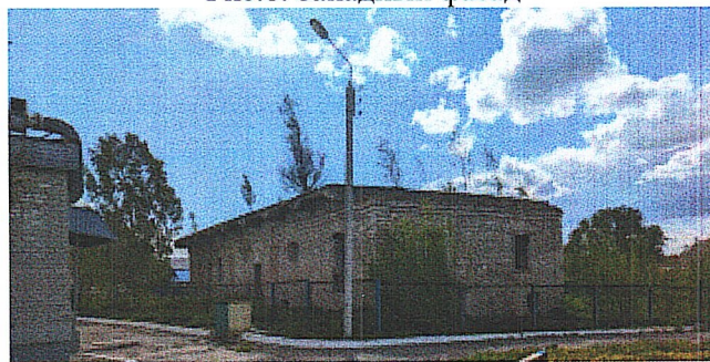
Рис.9. Северный и восточный фасады
