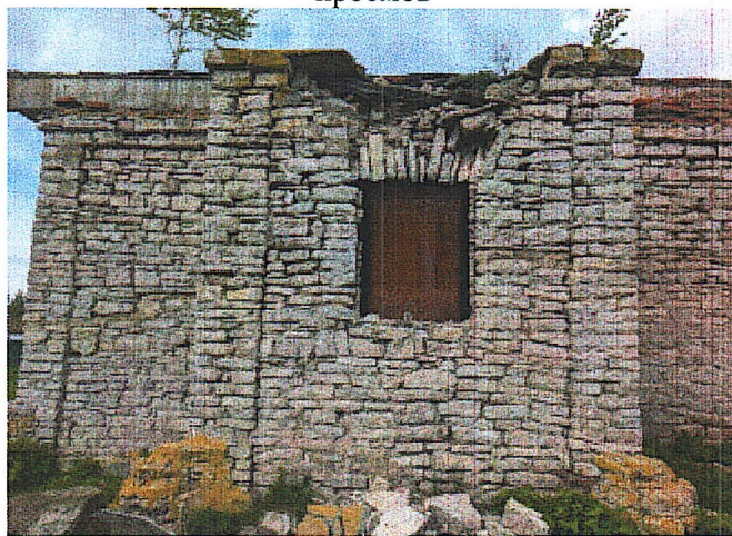
Рис.6. Углы здания, оформленные лопатками
