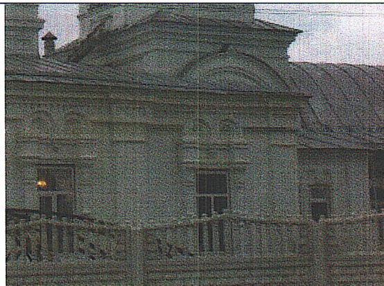
Рис.7. Вид с севера
