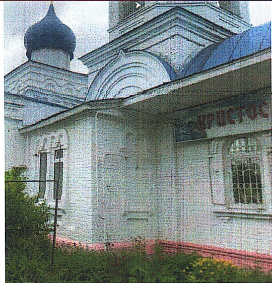
Рис.11. Вид с севера
