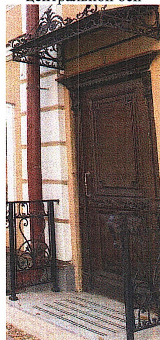
Рис.25. Заполнение дверного проема главного входа
