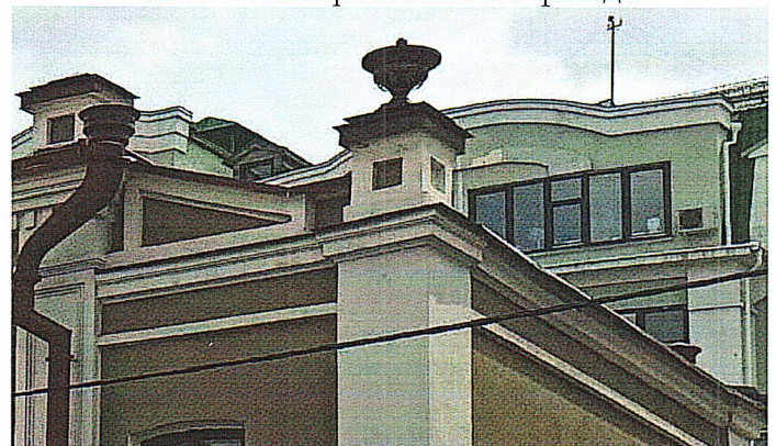
Рис.13. Металлический декоративный угловой вазон бокового пристроя со стороны ул. Карла Маркса
