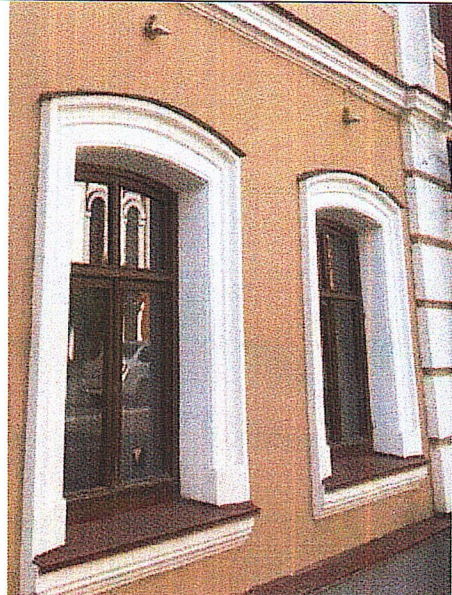
Рис.23. Оконные проемы первого этажа северо - восточного фасада
