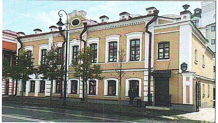
Рис.10. Фасад по ул. Карла Маркса
