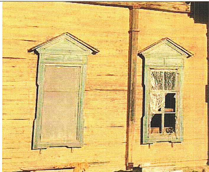
Фото.18. Оконные заполнения западного фасада
