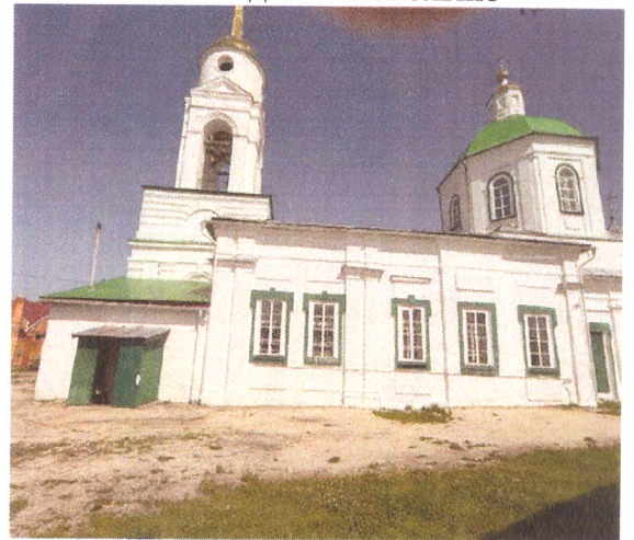
Рис.7. Вид на фрагмент юго-восточного фасада
