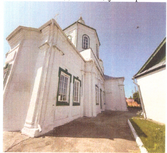
Рис.10. Вид на фрагмент северо-западного фасада
