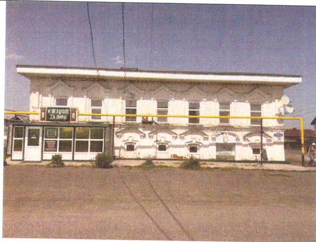
Рис.4. Фасад здания с ул. К. Либкнехта
