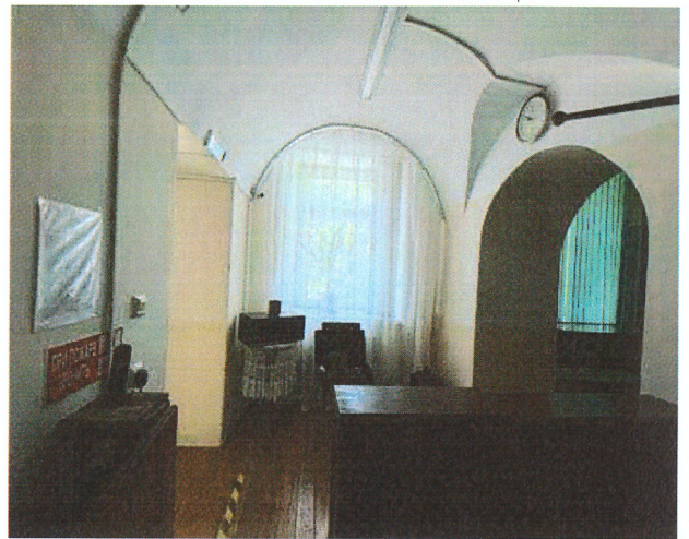
Рис.7. Цилиндрический свод в помещении первого этажа
