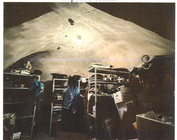
Рис.8. Сомкнутый свод в помещении второго этажа
