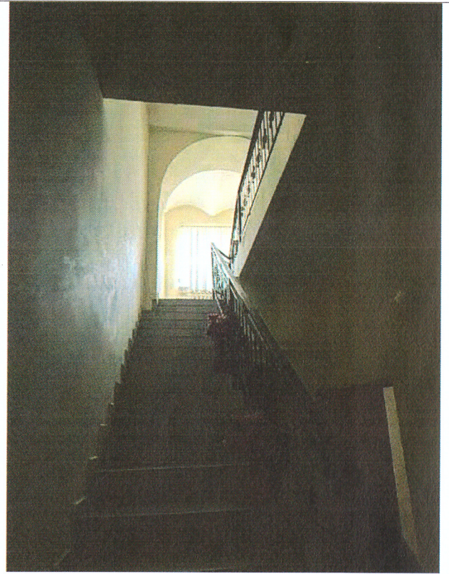
Рис.9. Вид на свод по типу «Монье»
