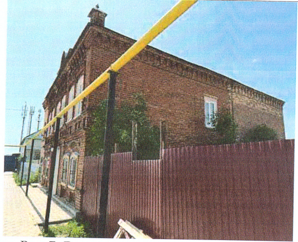
Рис.7. Вид на северо-восточный фасад здания
