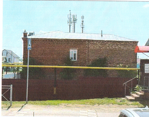
Рис.4. Вид на северо-восточный фасад здания
