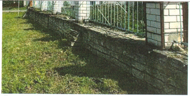
Рис.11. Цокольная часть церковной ограды по северной границе территории объекта культурного наследия
