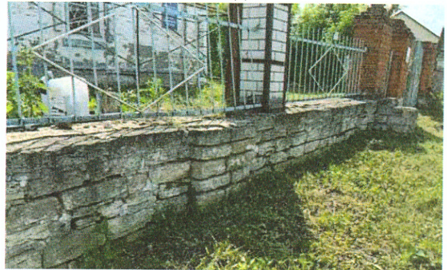
Рис.12. Цокольная часть церковной ограды по северной границе территории объекта культурного наследия
