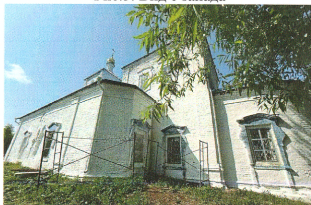
Рис.6. Вид южного фасада
