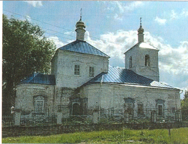
Рис.4. Вид с северо-востока
