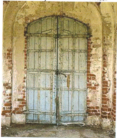
Рис.15. Дверное заполнение главного входа
