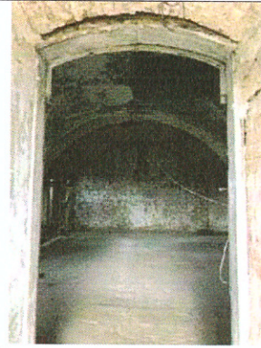
Рис.23. Арочные своды и проемы
