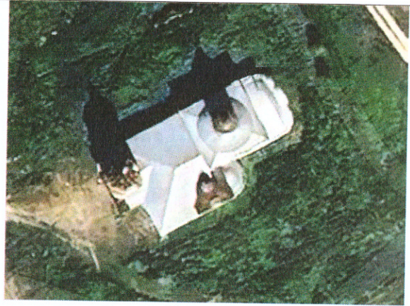
Рис.4. Вид на крышу
