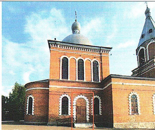
Рис.12. Северный фасад церкви
