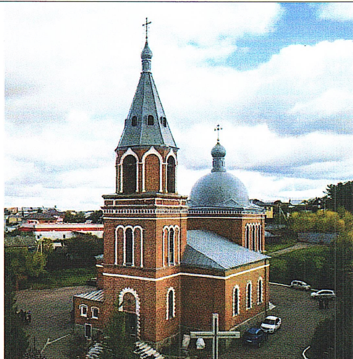
Рис.9. Вид объекта с юго-запада
