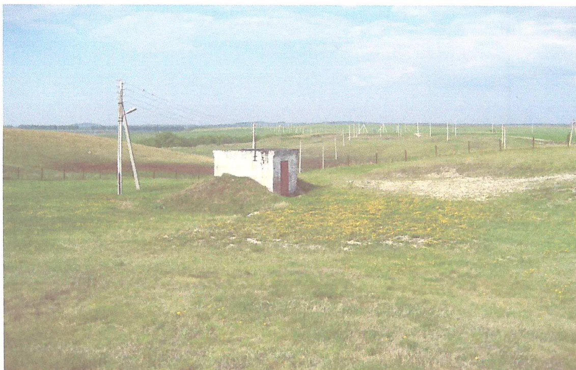
Скважина Чатринского водозабора
