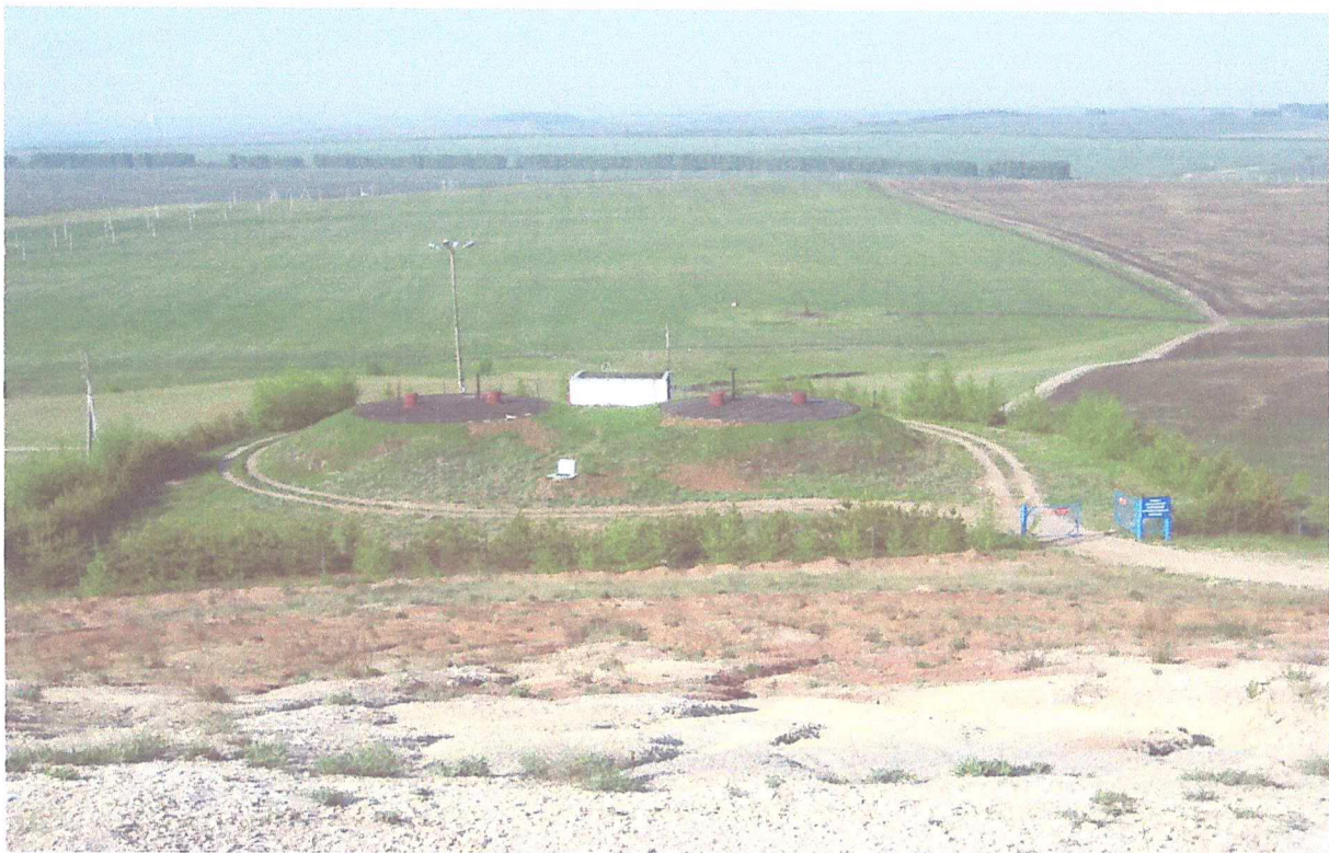
Резервуар чистой воды на Чатринском водозаборе Характеристика скважин Чатринского водозабора
