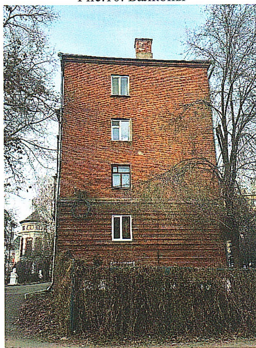
Рис. 11 Торцевой (юго-восточный) фасад
