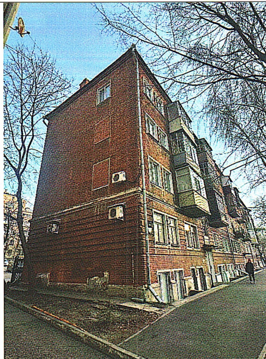
Рис.12 Торцевой (северо-западный) фасад
