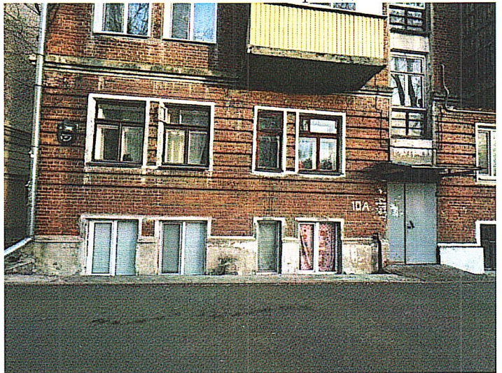
Рис.6. Оконные проемы первого и второго этажей
