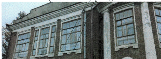
Рис.25. Оформление оконных проемов второго этажа бокового (восточного) фасада
