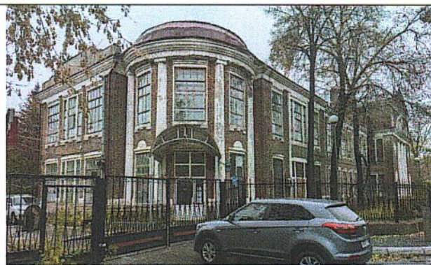
Рис.14. Общий вид двухэтажных объемов северного фасада
