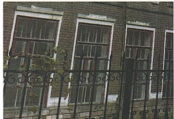
Рис.17-18. Оформление оконных проемов первого этажа северного фасада
