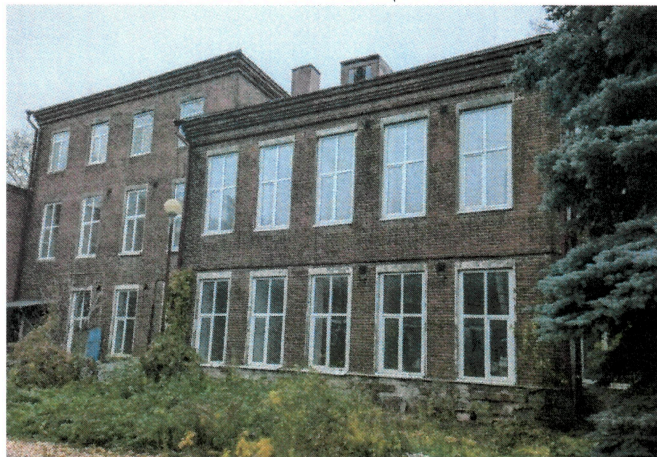
Рис.28. Общий вид, оформление дворового фасада
