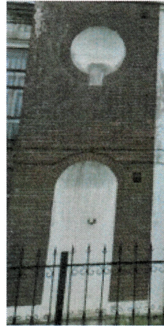
Рис.23. Декоративное оформление неглубокими нишками северного фасада
