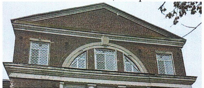
Рис.22. Оформление северного фасада третьего этажа
