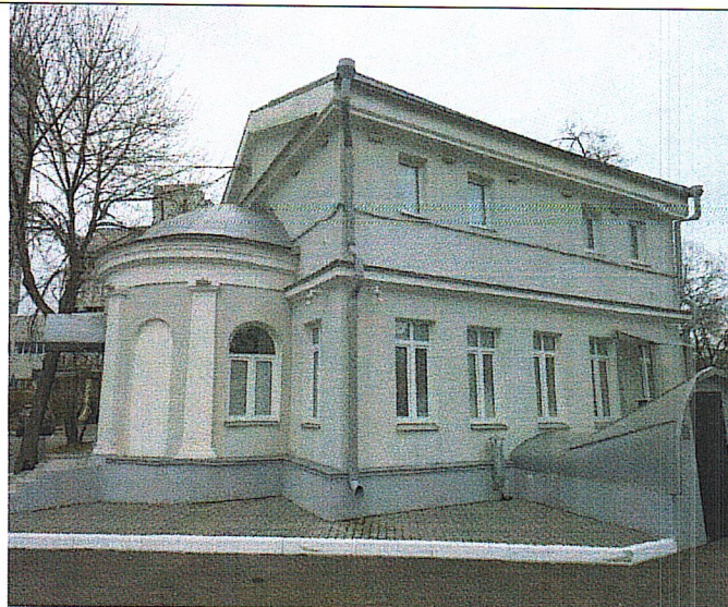
Рис.12. Вид на юго-восточный фасад
