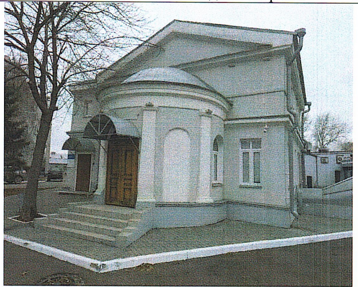
Рис.16. Местоположение дверных проемов
