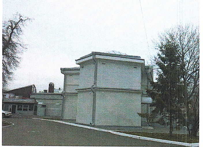
Рис.15. Вид с юго-западной стороны
