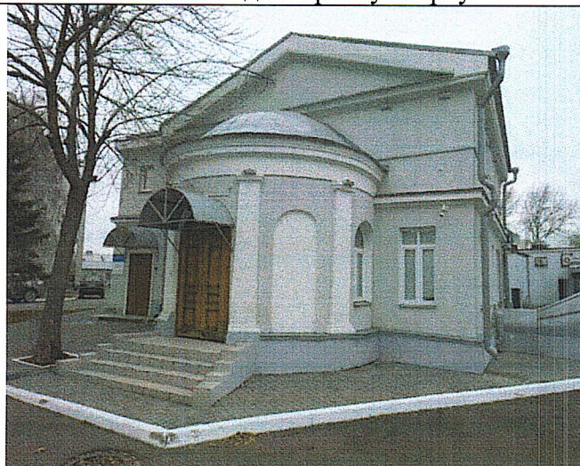
Рис.11. Вид с южной стороны
