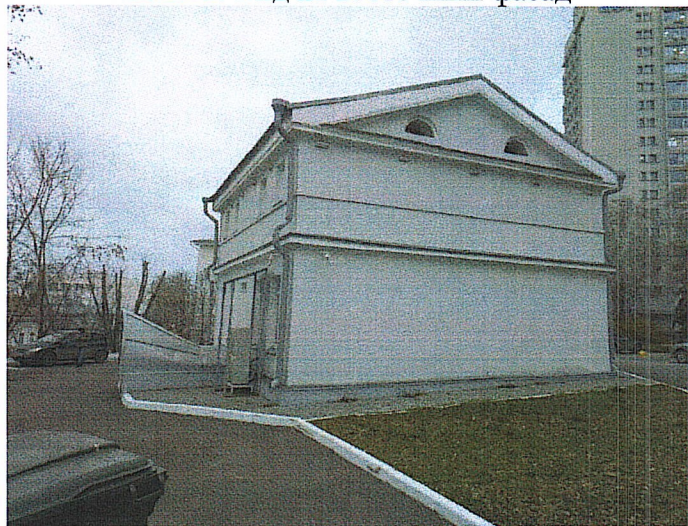
Рис.14. Вид на северный фасад
