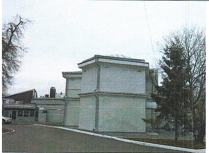
Рис.3. Вид с юго-западной стороны
