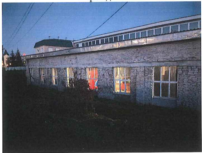
Рис.14. Вид со стороны внутреннего двора
