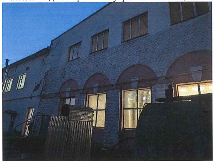
Рис.9. Вид с восточной стороны. Оконные проемы
