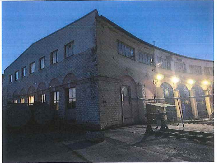
Рис.6. Вид на главный фасад с восточной стороны
