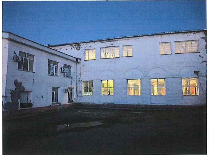
Рис.12. Вид со стороны двора
