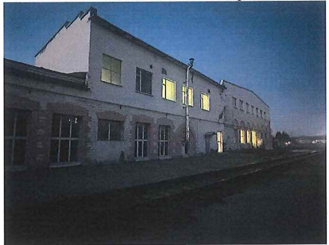
Рис.4. Вид с южной стороны
