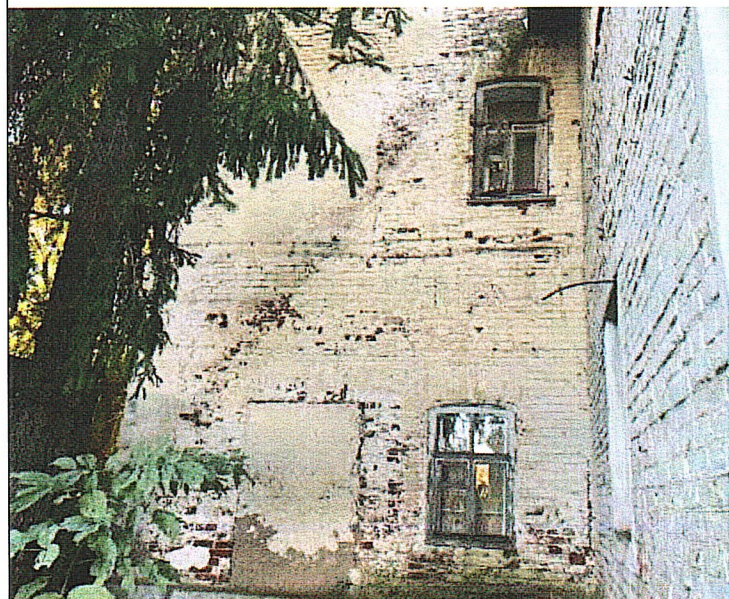
Рис. 11. Вид северо-восточного дворового фасада
