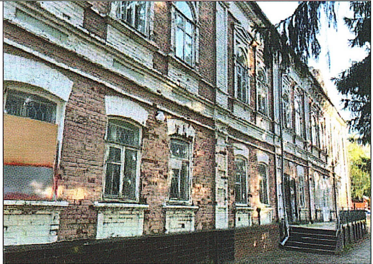
Рис. 6. Северо-западный фасад по ул. Октябрьской
