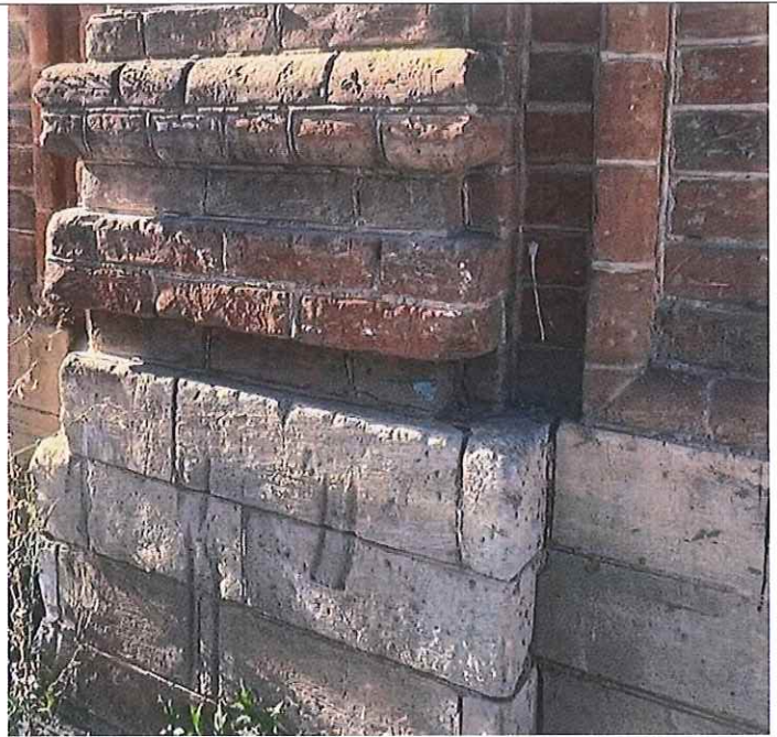
Рис. 11. Фрагмент кирпичной кладки и белокаменного цоколя
