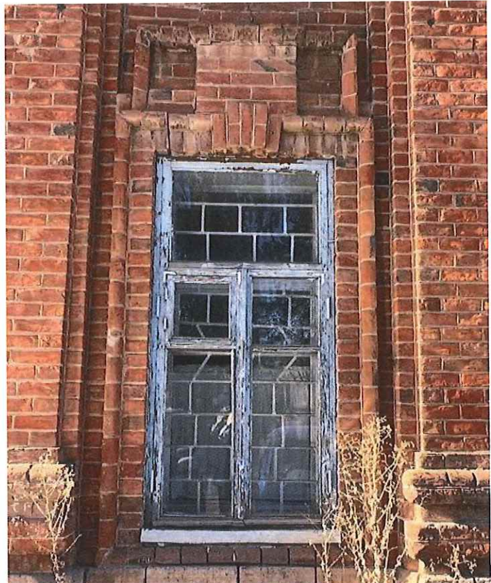
Рис. 8. Оформление окна первого этажа главного фасада
