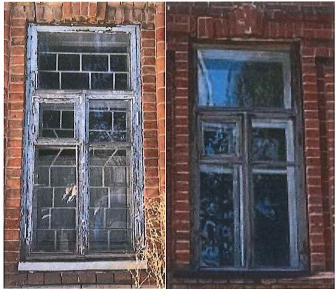
Рис. 14. Расстекловка окон первого и второго этажа главного фасада
