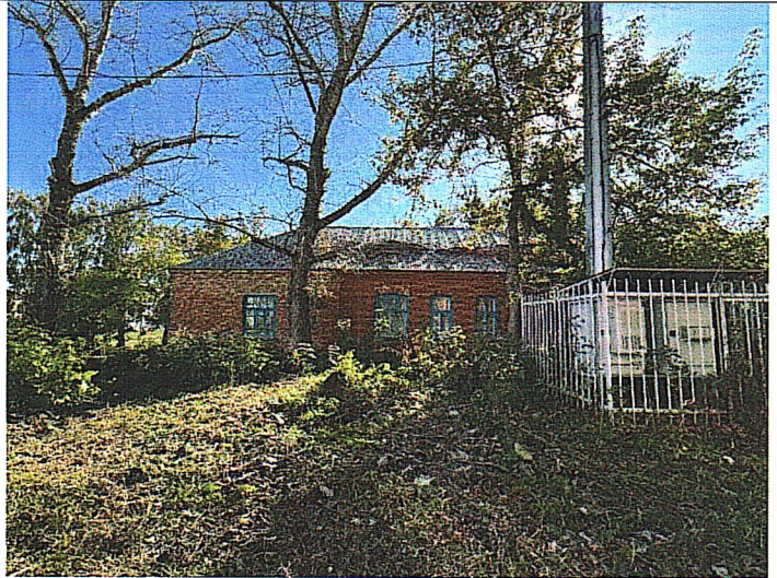
Рис. 7. Фрагмент северо-западного фасада
