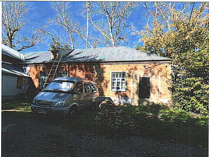
Рис. 10. Фрагмент юго-восточного фасада
