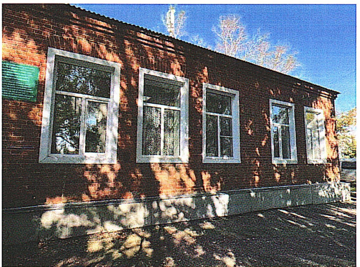
Рис. 9. Фрагмент юго-восточного фасада
