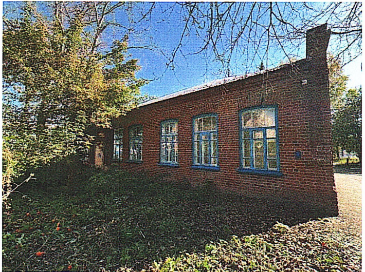
Рис. 8. Фрагмент северо-западного фасада
