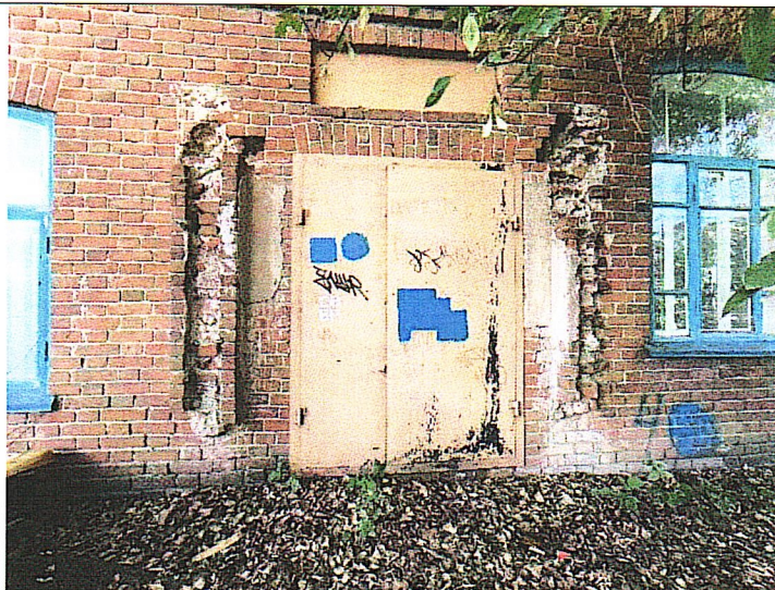
Рис. 17. Вид в юго-восточном направлении на входную группу на северо-восточном фасаде
