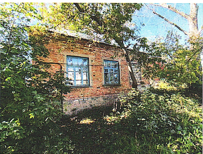
Рис. 12. Северо-восточный фасад здания
