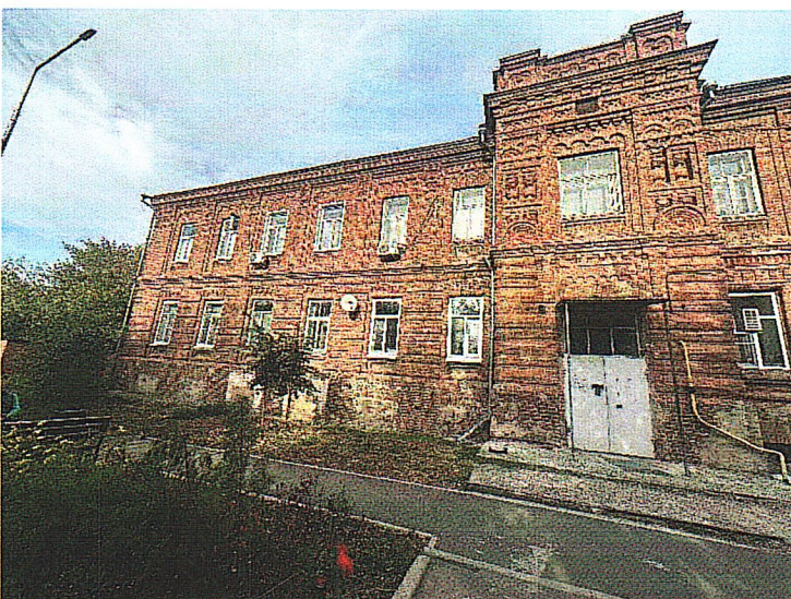
Рис. 10. Фрагмент юго-западного фасада
