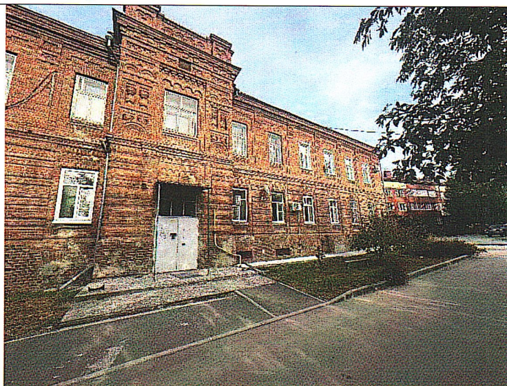
Рис. 11. Фрагмент юго-западного фасада
