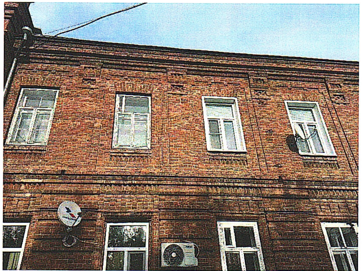
Рис. 14. Оконные проемы второго этажа
