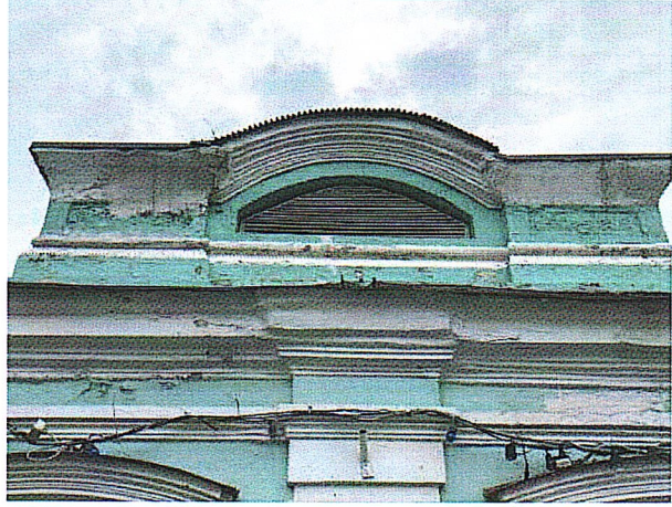
Рис.8. Атик с фланкирующими тумбами и лучковым оконным проемом.
