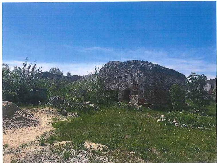
Рис.4. Вид с северо-западной стороны
