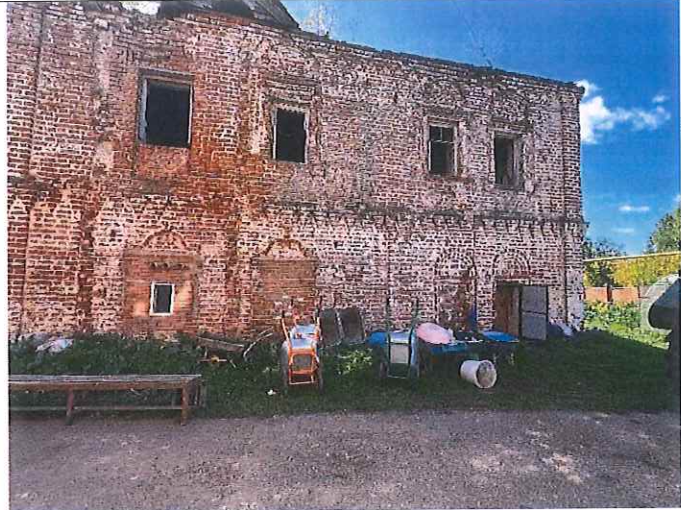
Рис.12. Вид с северной стороны
