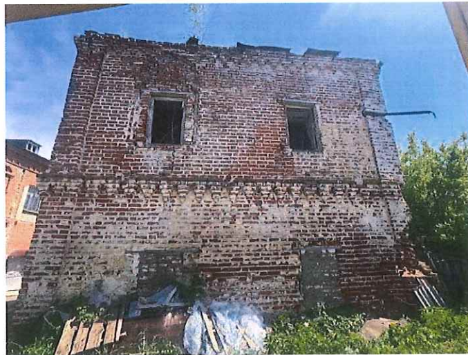
Рис.10. Вид с западной стороны
