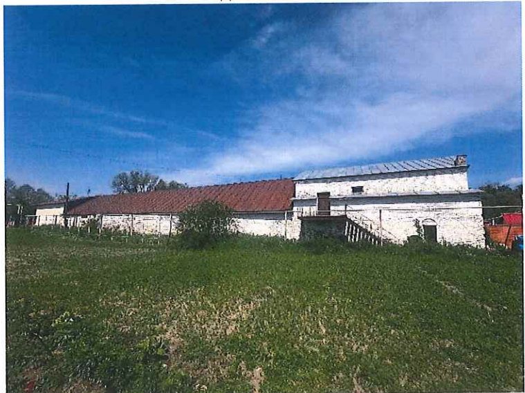
Рис.13. Общий вид с южной стороны
