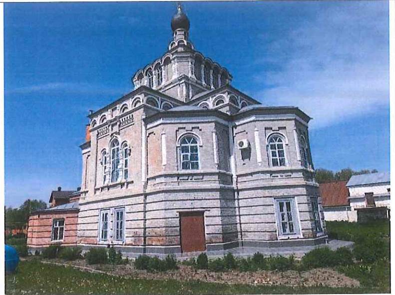
Рис. 3. Вид с северной стороны
