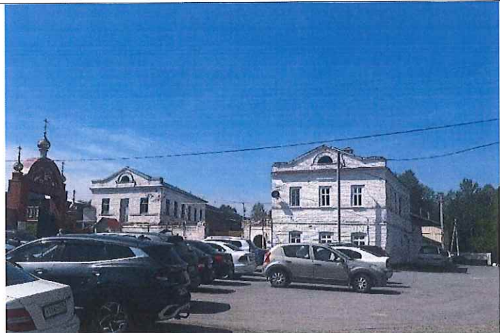
Рис.6. Вид с восточной стороны
