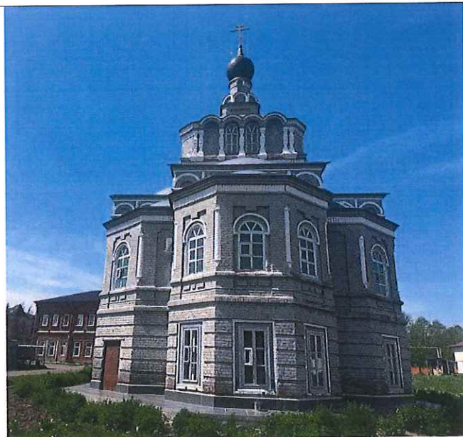
Рис.14. Вид с восточной стороны
