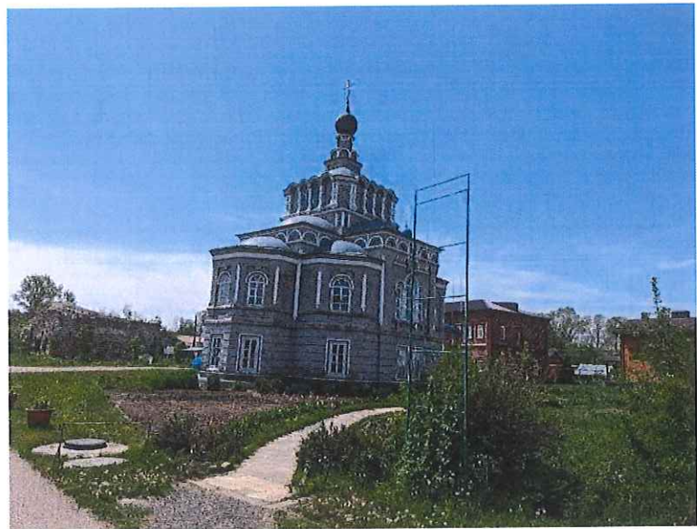
Рис.16. Вид с северной стороны
