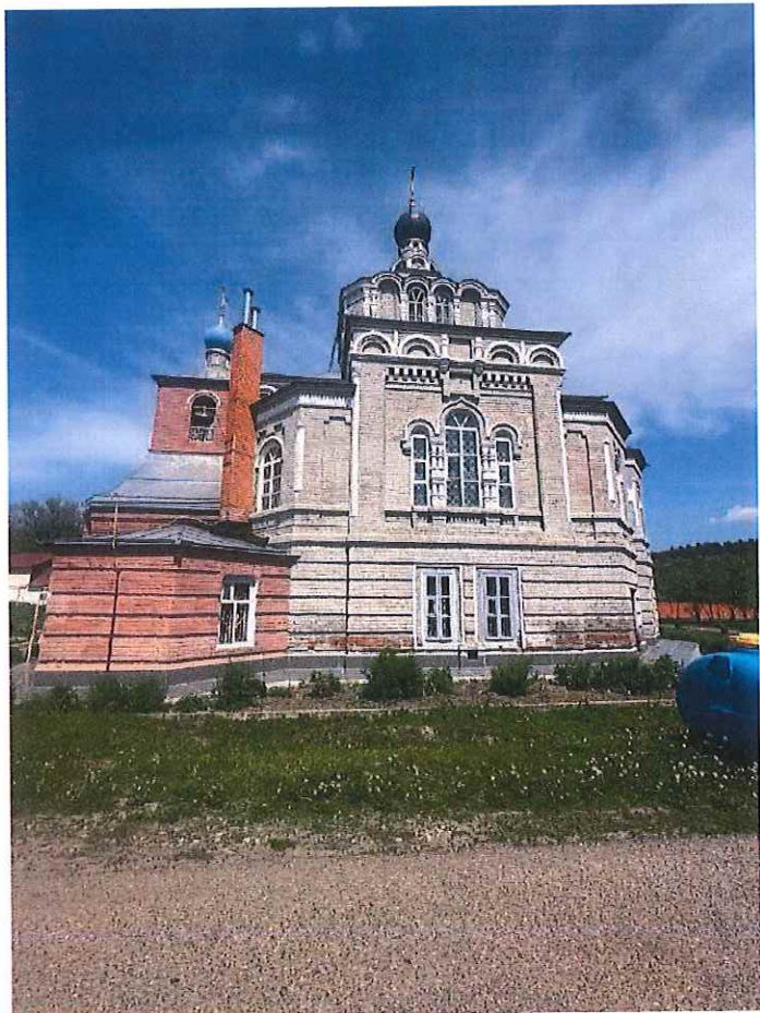
Рис.18. Вид с южной стороны
