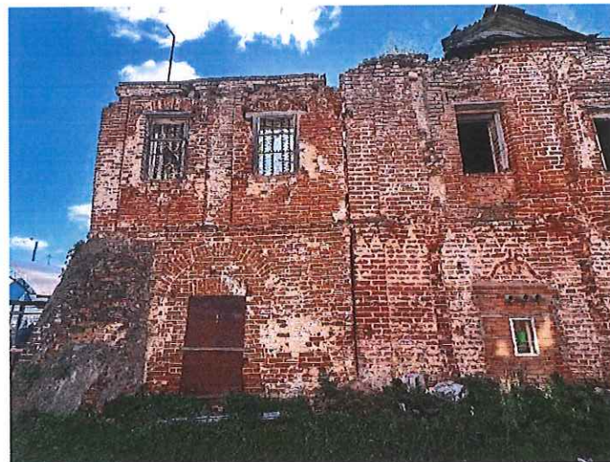
Рис.11. Вид с северной стороны
