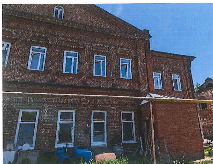
Рис.10. Часть восточного фасада
