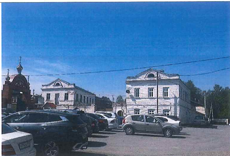
Рис.8. Вид с восточной стороны
