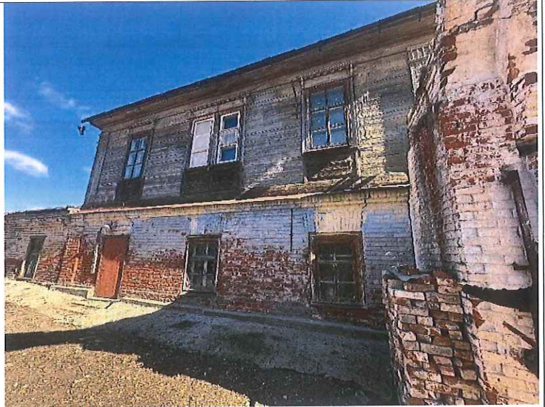
Рис.13. Фрагмент южного фасада
