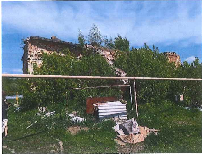
Рис.9. Вид с южной стороны
