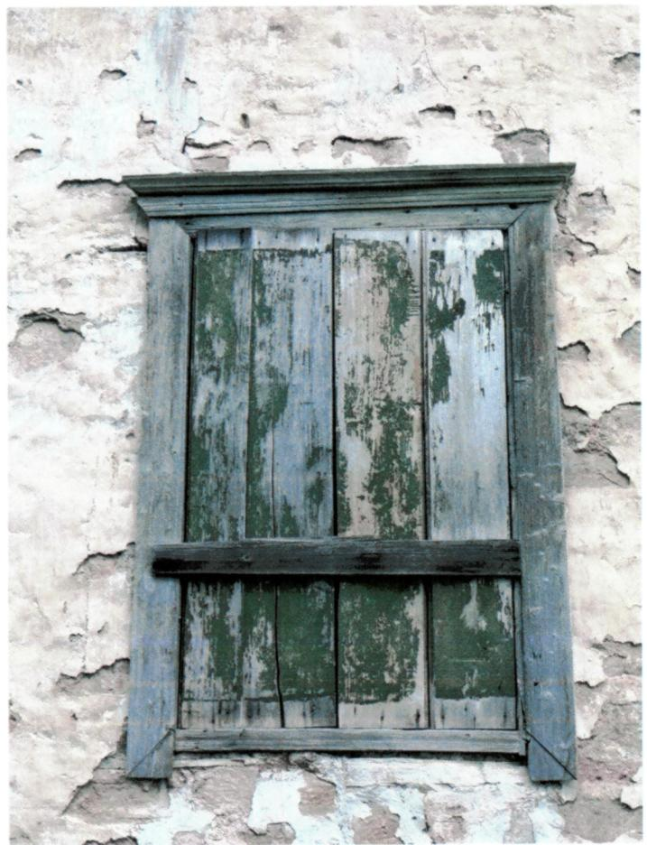
Рис. 35. Оконный проем в обрамлении простого рамочного наличника с профильным ступенчатым карнизом
