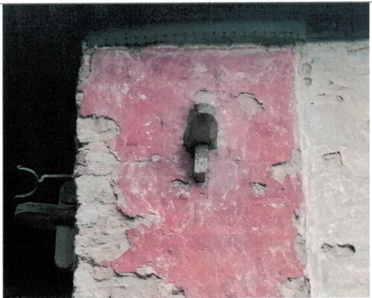
Рис. 32. Выступающие из кладки каменных стен элементы деревянных конструктивных связей
