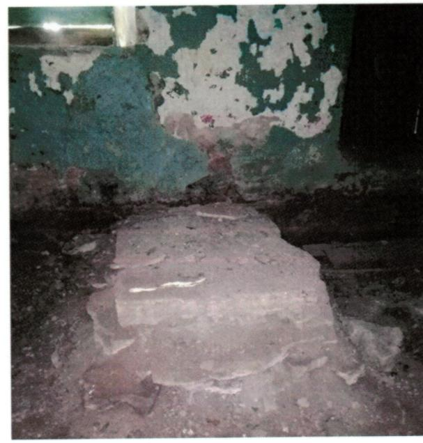
Рис. 9. Выступ фундамента от плоскости стены
