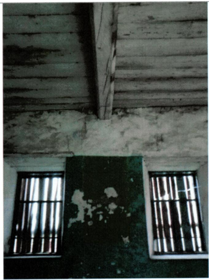
Рис. 28. Деревянные перемычки оконных проемов
