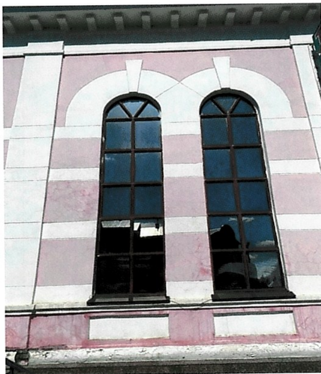
Оконные проемы фасада по ул. К. Маркса
