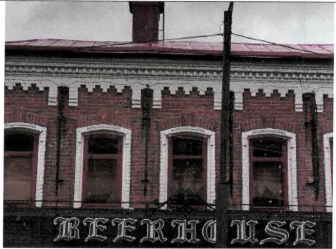
Оконные проемы 2 этажа
