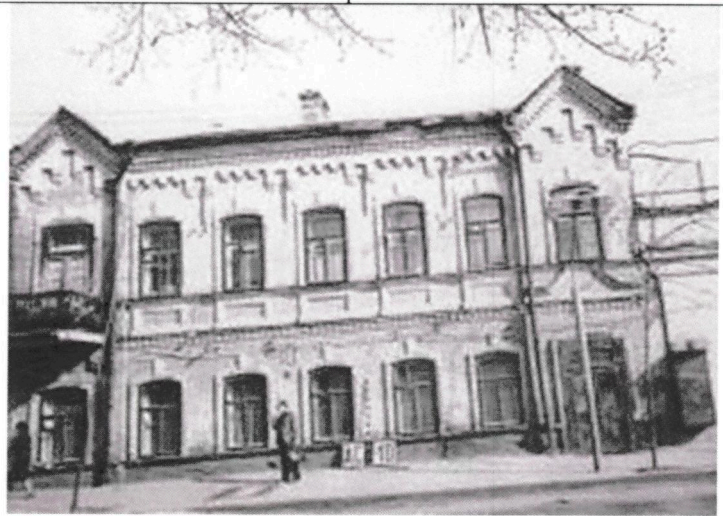
Главный фасад. Фото 1980-х гг.
