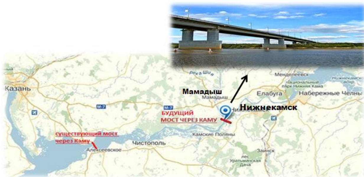
Рис.18 Мост через р.Кама, строительство которого запланировано к 2018 г.
